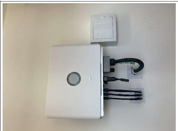
Fig. 14 – inversor (sistema fotovoltaico)
