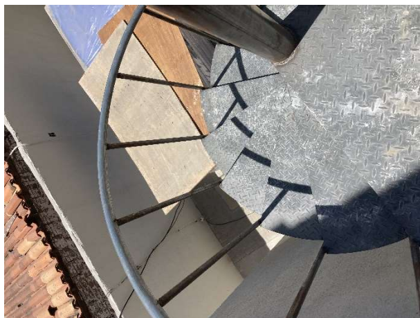
Fig. 17 – escada metálica (diversos)
