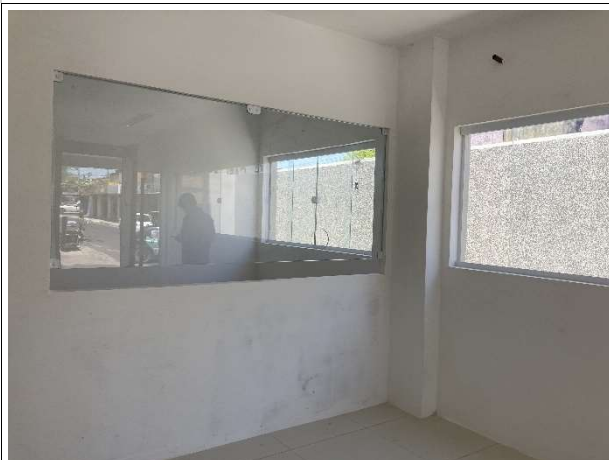
Fig. 13 – instalação de vidros
