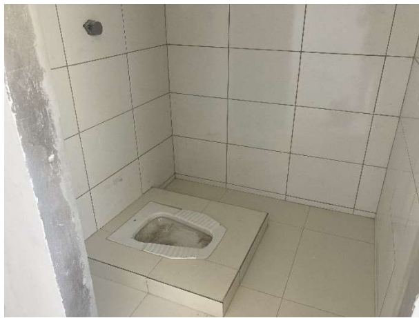
Fig. 15 – revestimentos e instalações hidrossanitárias
