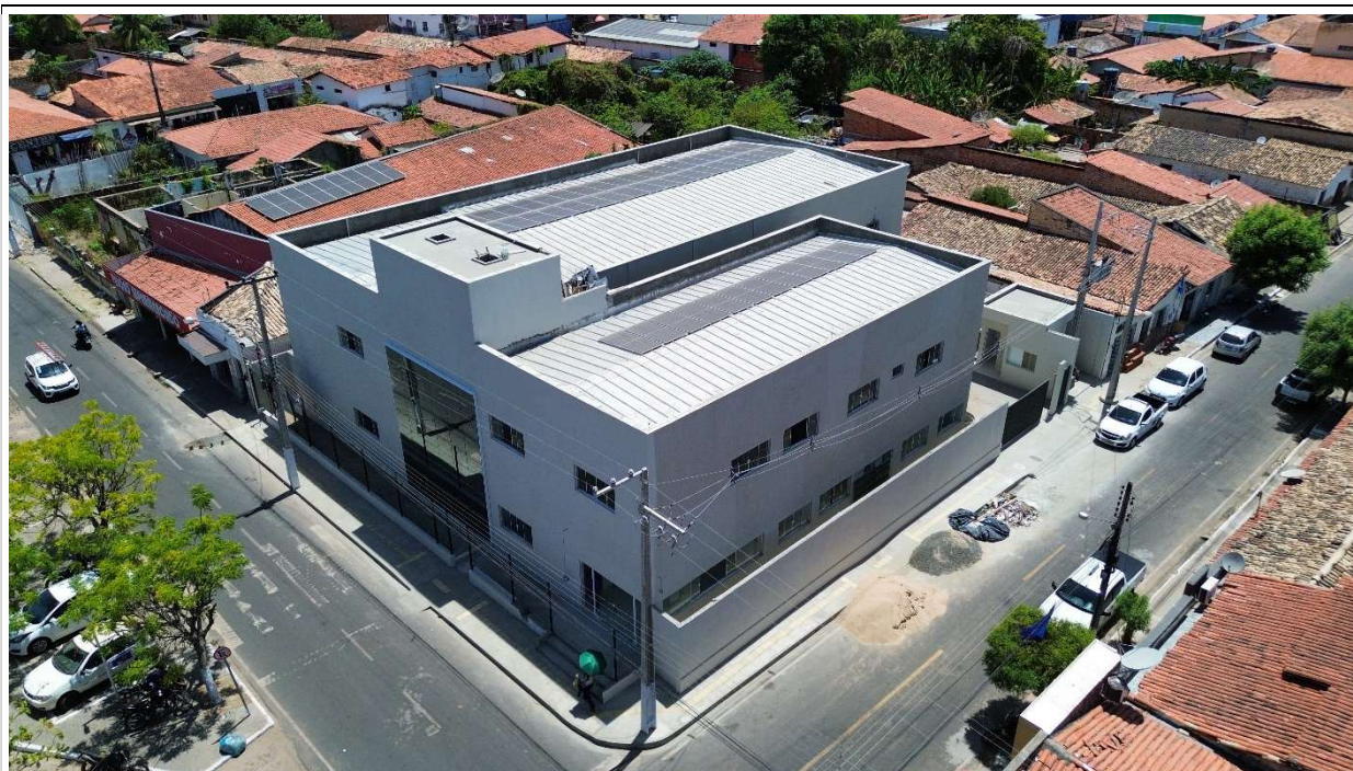
Fig. 1 – Vista aérea da obra
