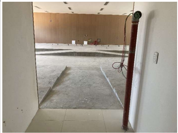
Fig. 16 – execução de instalações de combate a incêndio
