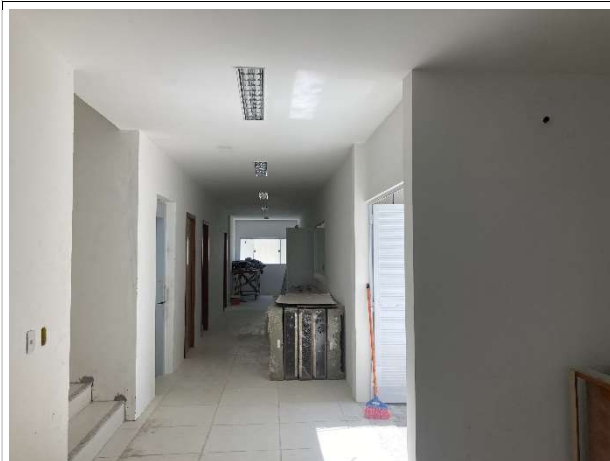
Fig. 5 – execução de piso, paredes, forro e instalações
