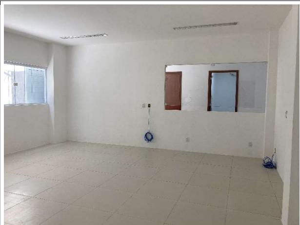
Fig. 6 – execução de piso, pintura, forro e instalações
