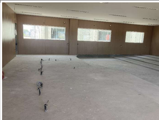
Fig. 11 – execução de instalações e revestimento em MDF
