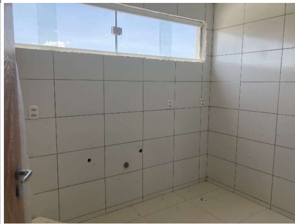
Fig. 9 – revestimentos e instalações hidrossanitárias
