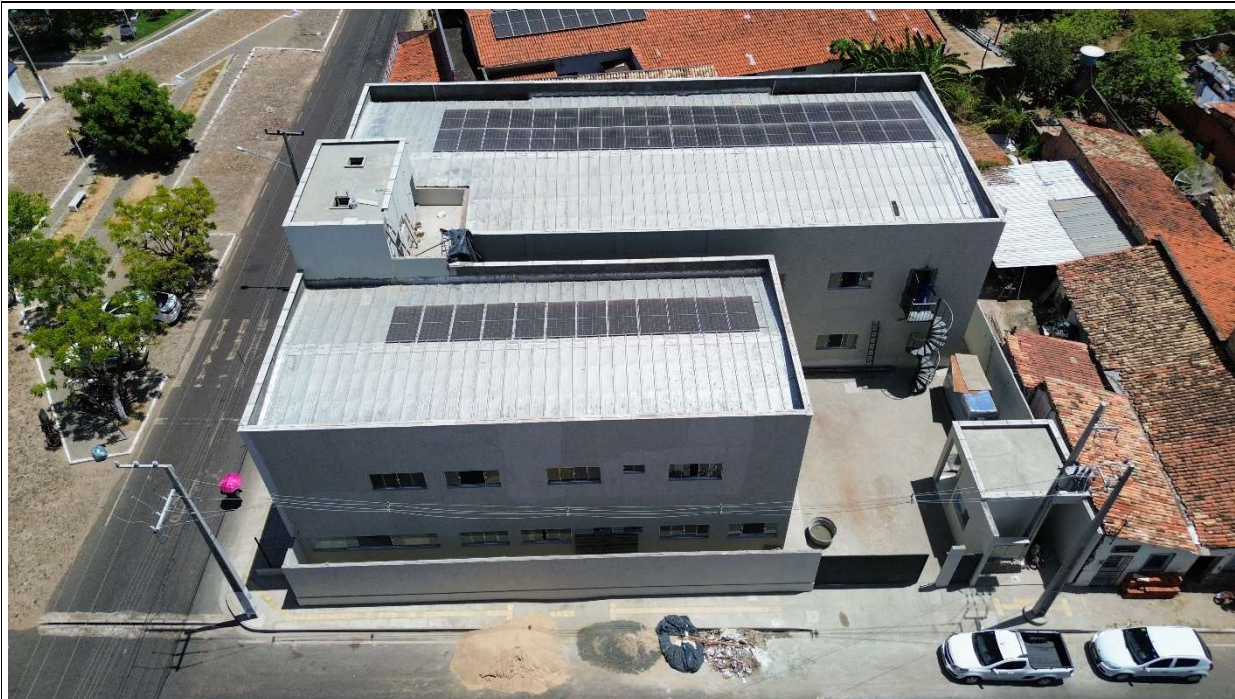
Fig. 2 – Vista aérea da obra
