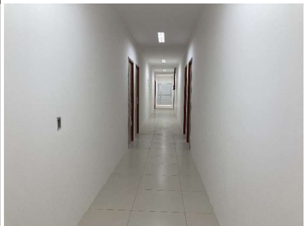
Fig. 6 – execução de piso, pintura, forro e instalações
