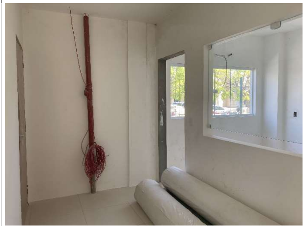
Fig. 16 – execução de instalações de combate a incêndio
