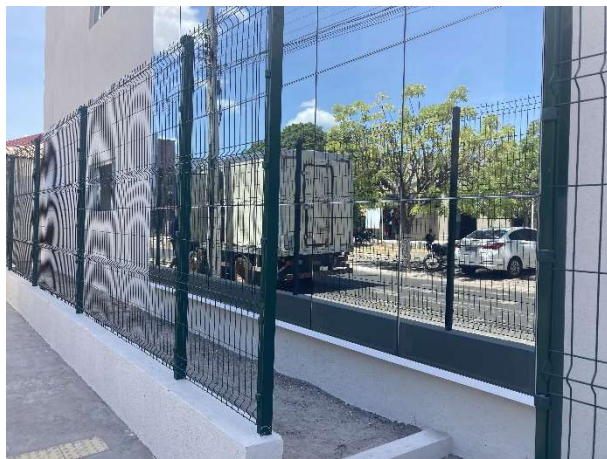
Fig. 3 – execução de esquadrias de vidro e gradil metálico
