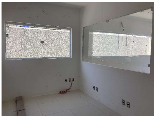
Fig. 5 – execução de piso, paredes, forro e esquadrias
