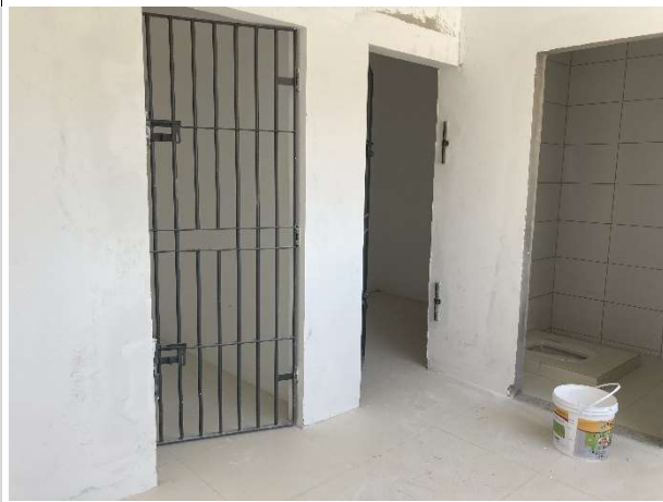
Fig. 15 – esquadrias e instalações hidrossanitárias
