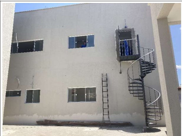
Fig. 8 – esquadrias de vidro, pintura e escada metálica
