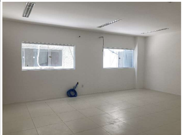
Fig. 4 – execução de piso, pintura, forro e instalações
