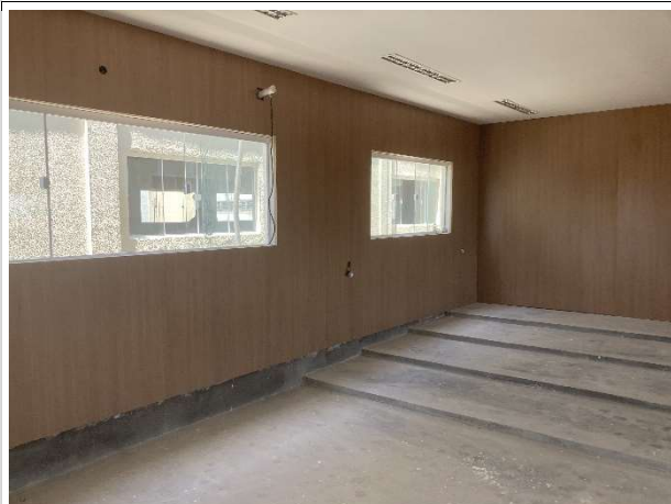
Fig. 11 – execução de instalações e revestimento em MDF
