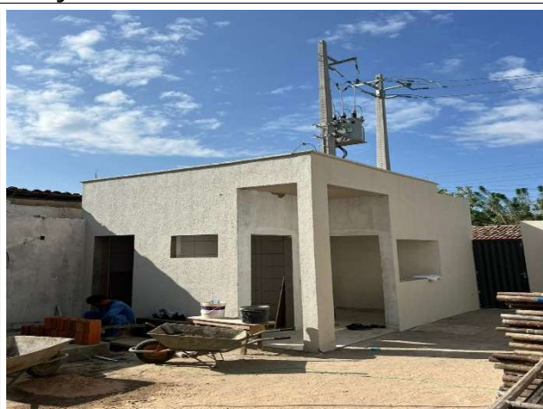
Fig. 2 – execução de pintura da guarita
