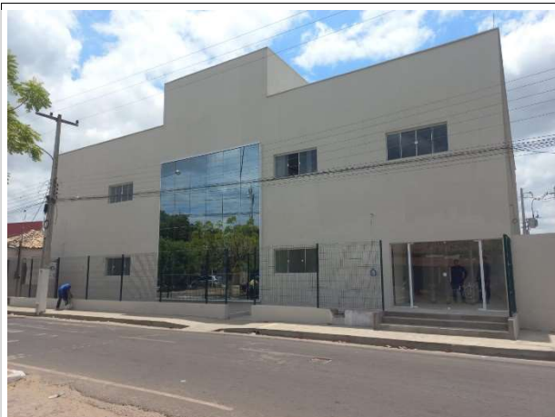
Fig. 1 – execução de pintura e esquadrias de vidro da fachada
