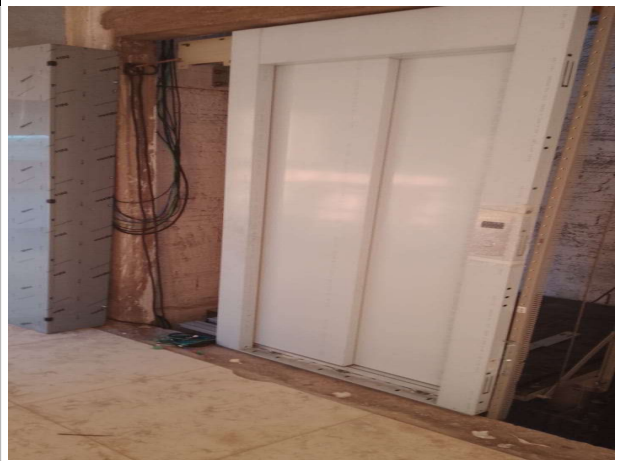
Fig. 8 – instalação do elevador (serviços diversos)
