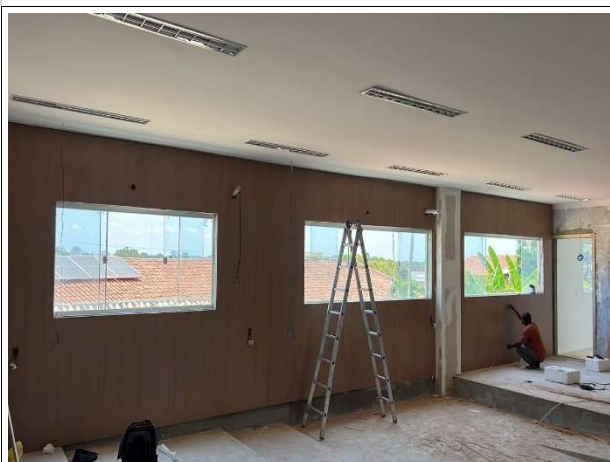
Fig. 5 – revestimento em MDF e instalações elétricas
