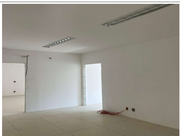
Fig. 6 – execução de instalações elétricas e lógicas
