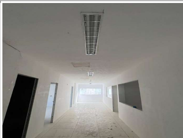
Fig. 3 – execução de piso, forro, instalações e pintura
