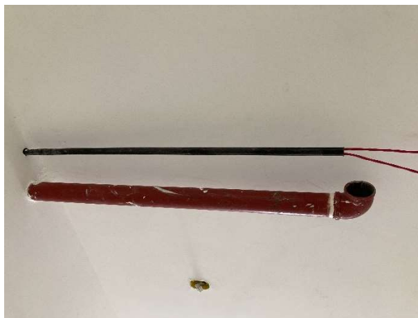
Fig. 9 – execução de instalações de combate a incêndio
