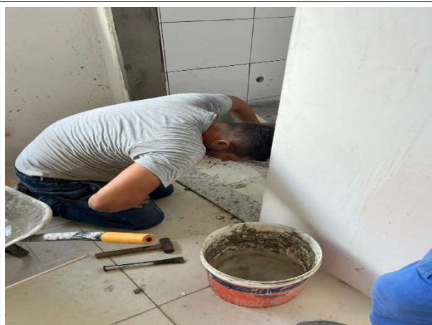
Fig. 4 – execução de piso e revestimentos
