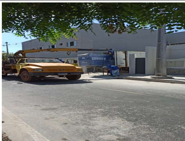
Fig. 11 – assentamento do grupo gerador
