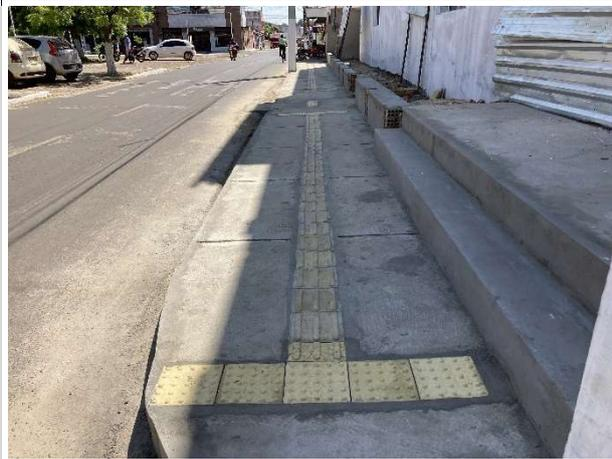
Fig. 3 – execução de piso tátil e calçada
