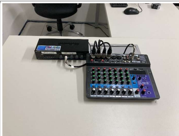
Fig. 10 – Instalações de sonorização
