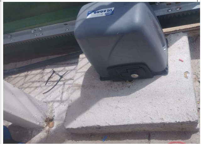
Fig. 22 – Instalação de motor de portão
