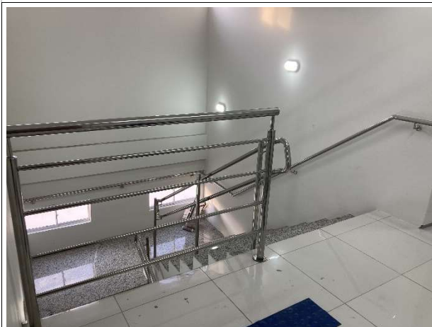
Fig. 19 – Guarda-corpo e corrimão de inox (diversos)
