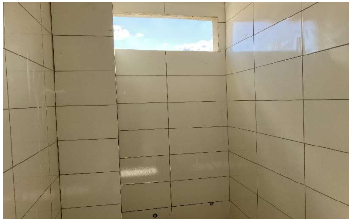
REVESTIMENTO DOS BANHEIROS
