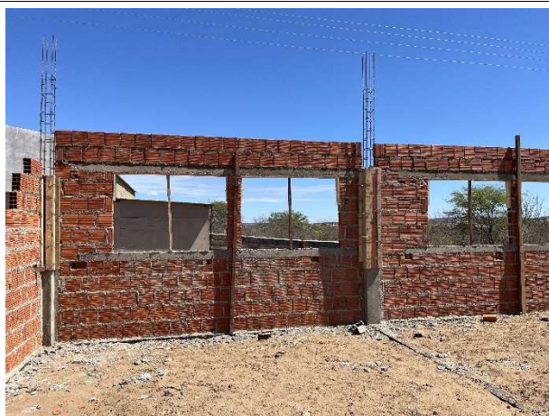
Foto 11 – Superestrutura (pilares/vergas/contravergas)
