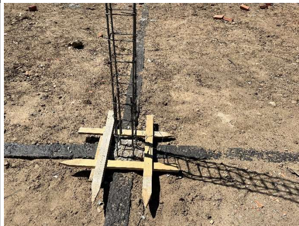
Foto 4 – Execução de infraestrutura (baldrame)
