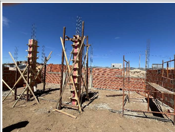
Foto 8 – Execução de superestrutura e alvenaria
