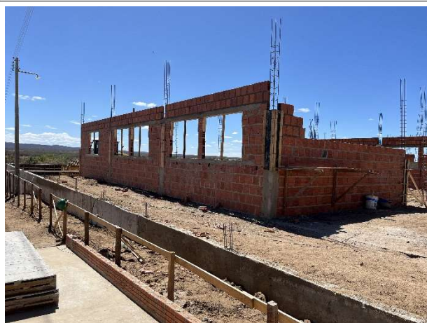
Foto 12 – Muro de arrimo da edificação
