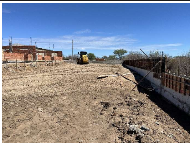
Foto 5 – Execução de infraestrutura (muro de arrimo)
