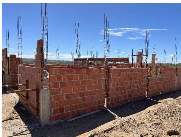
Foto 7 – Execução de superestrutura e alvenaria
