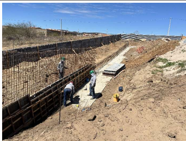
Foto 10 – Execução de infra/superestrutura (muro de arrimo)
