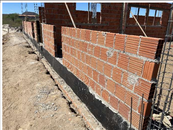
Foto 6 – Execução de infraestrutura (baldrame) e alvenaria
