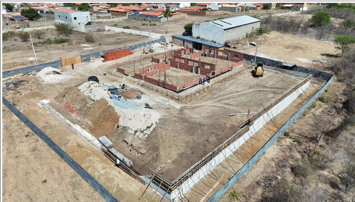
Foto 2 – Vista aérea da obra em 10/07/2025
