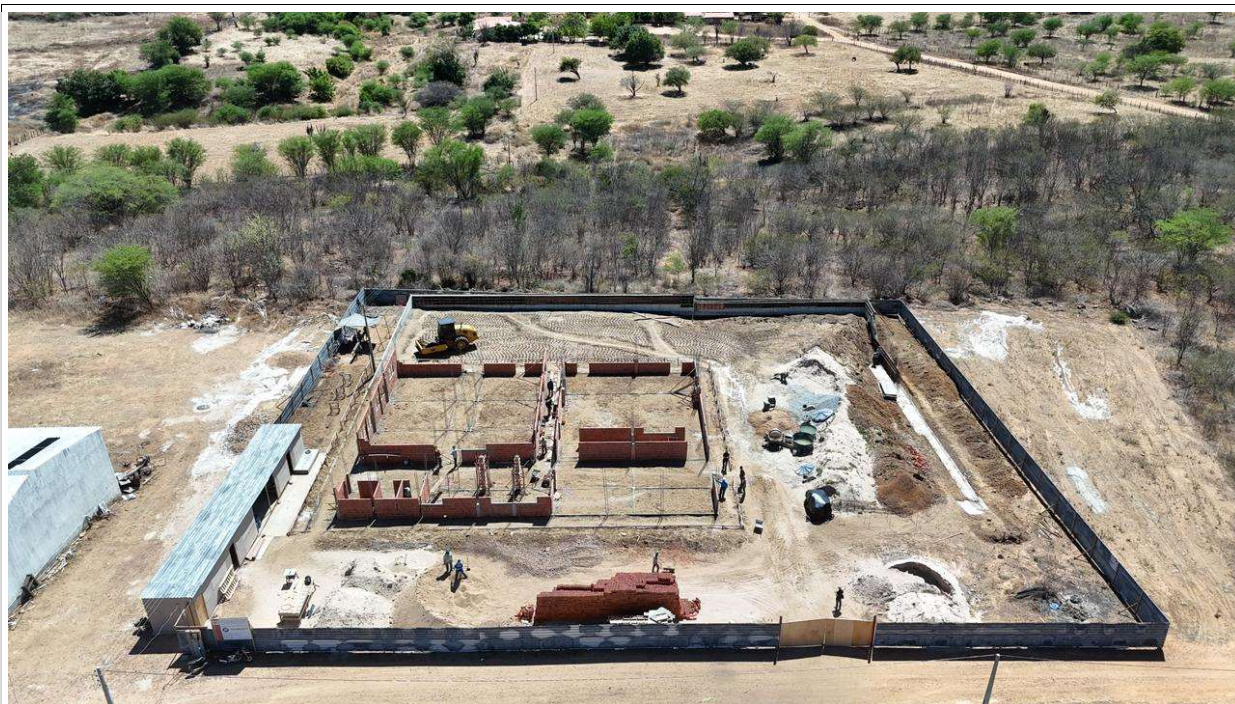
Foto 1 – Vista aérea da obra em 10/07/2025
