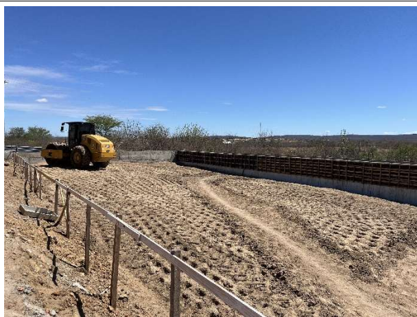
Foto 9 – Execução de infra/superestrutura (muro de arrimo)
