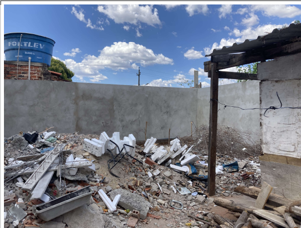
Fig. 17 – execução de demolição e retiradas
