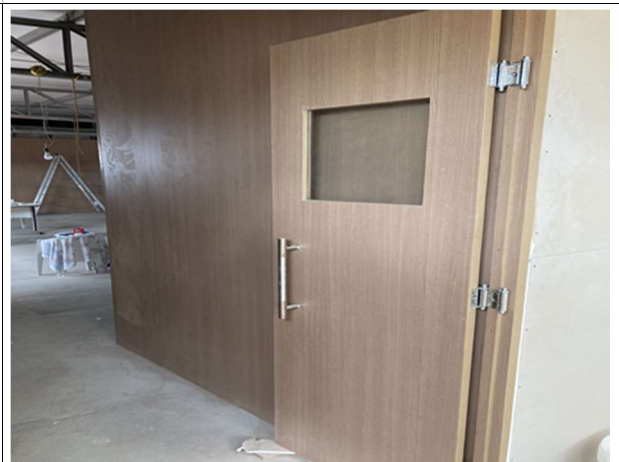
Fig. 8 – execução de esquadria de madeira
