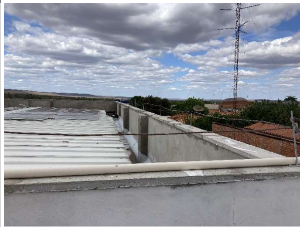
Fig. 15 – execução de malha de SPDA e calha da cobertura
