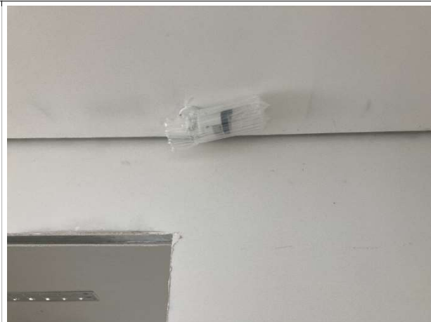
Fig. 12 – instalação de câmeras de CFTV
