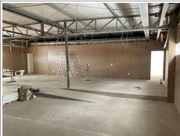
Fig. 7 – execução de revestimento em MDF no auditório
