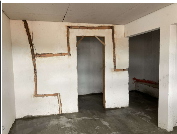
Fig. 19 – execução de contrapiso e alvenaria
