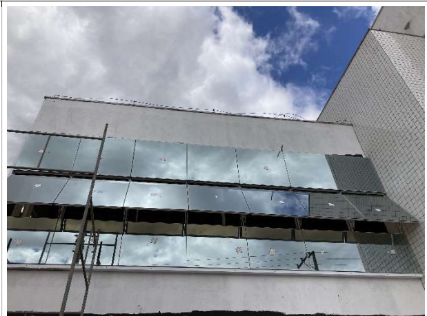
Fig. 6 – execução de esquadria em pele de vidro
