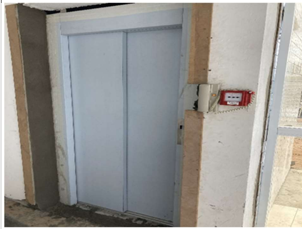
Fig. 9 – instalação de elevador
