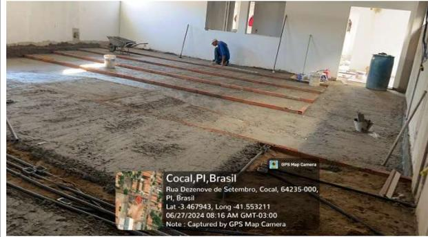
Fig. 11 – (11.1 – Revestimento de Pisos Internos)
