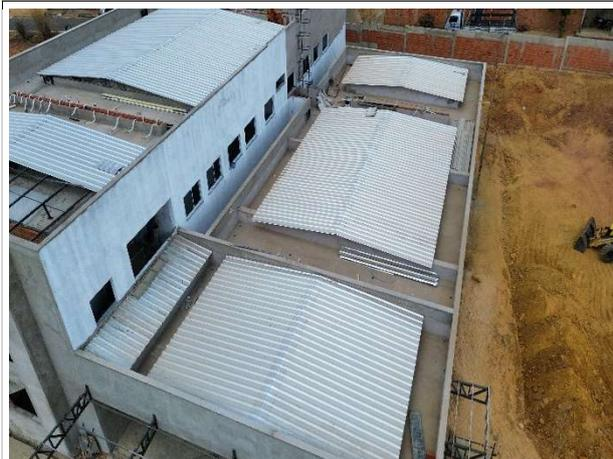
Fig. 5 – Execução de cobertura e impermeabilização
