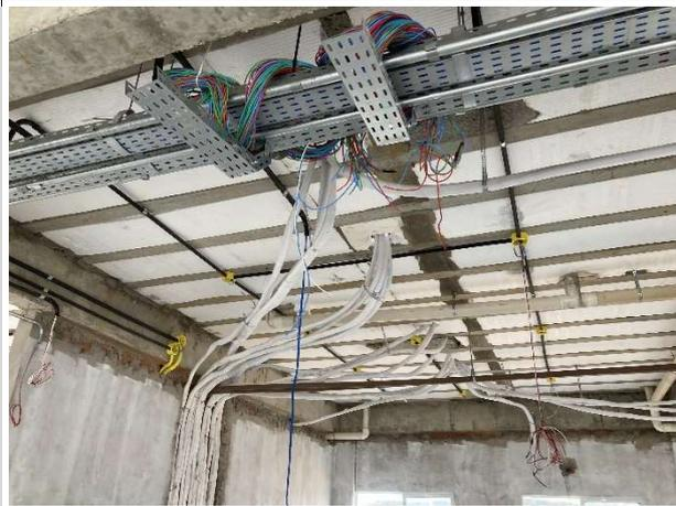
Fig. 9 – Execução de instalações elétricas e frigorígenas
