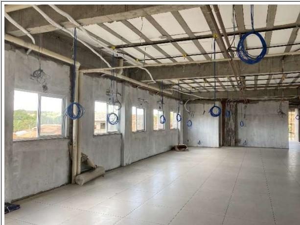
Fig. 7 – Execução de piso e instalações elétricas
