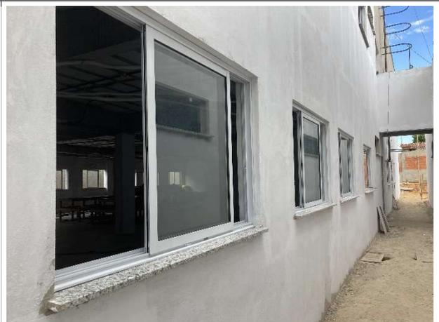
Fig. 6 – Execução de esquadrias e pintura
