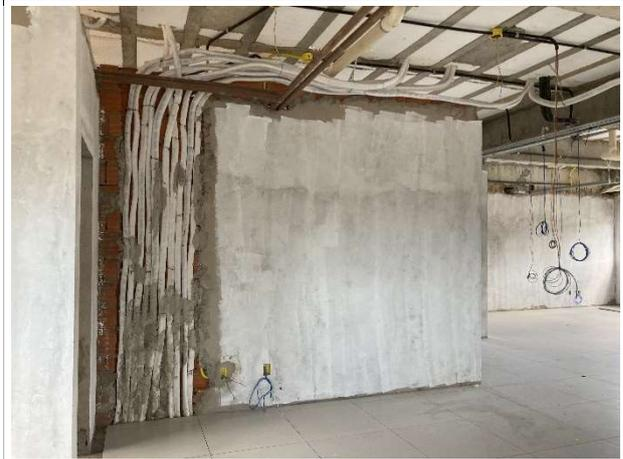
Fig. 10 – Execução de instalações elétricas e frigorígenas
