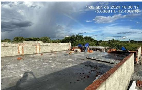
Fig. 11 – (4 paredes e painéis) – Assentamento de Alvenaria
