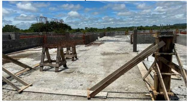
Fig. 3 – (2.3 Superestrutura) – Viga superior armação e forma
