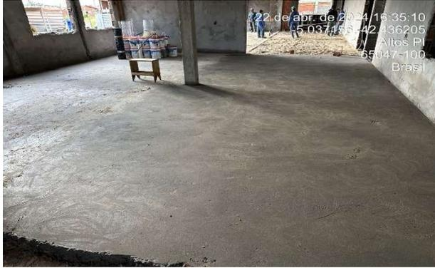
Fig. 32 – (8.1 Pavimentação Interna) - Contrapiso
