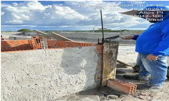
Fig. 2 – (2.3 Superestrutura) – Forma e concretagem de pilares
