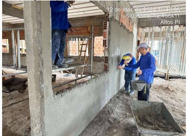
Fig. 22 – (7.2 revestimento externo) – Chapisco
