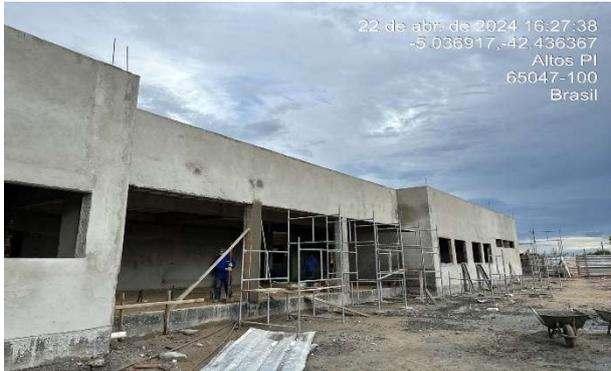
Fig. 27 – (7.2 revestimento externo) – Reboco
