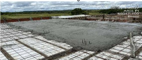
Fig. 8 – (2.3 Superestrutura) – Lajes – Armação e concretagem
