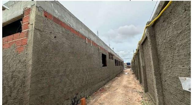
Fig. 24 – (7.2 revestimento externo) – Impermeabilização
