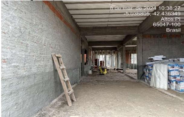
Fig. 17 – (7.1 revestimento interno) – Chapisco
