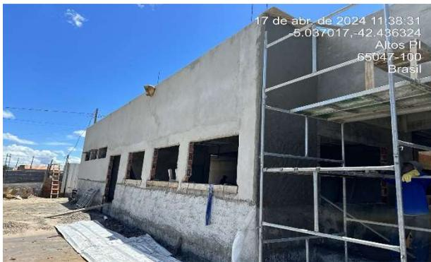
Fig. 29 – (7.2 revestimento externo) – Reboco
