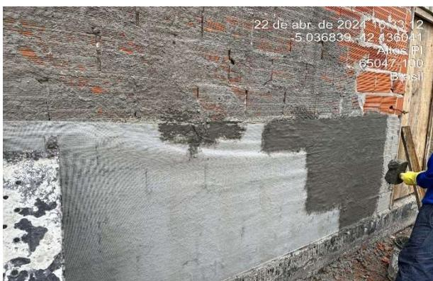
Fig. 25 – (7.2 revestimento externo) – Chapisco
