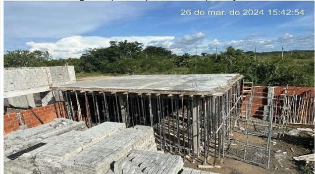
Fig. 7 – (2.3 Superestrutura) – Lajes – Armação e concretagem
