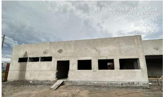
Fig. 28 – (7.2 revestimento externo) – Reboco
