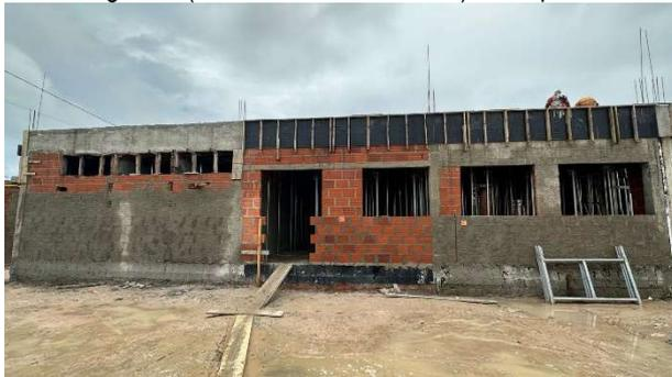
Fig. 23 – (7.2 revestimento externo) – Chapisco
