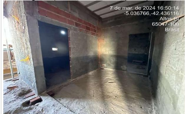
Fig. 18 – (7.1 revestimento interno) – Reboco
