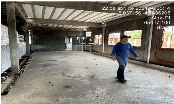
Fig. 31 – (8.1 Pavimentação Interna) - Contrapiso
