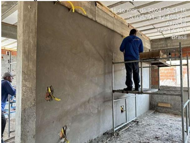
Fig. 19 – (7.1 revestimento interno) – Reboco
