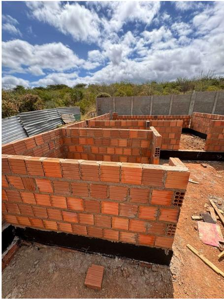
Fig. 13 – Baldrame e alvenaria da edificação
