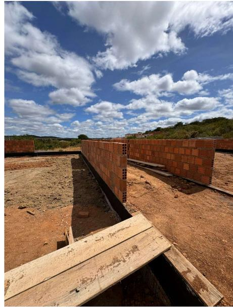
Fig. 14 – Execução de movimento de terra e viga baldrame
