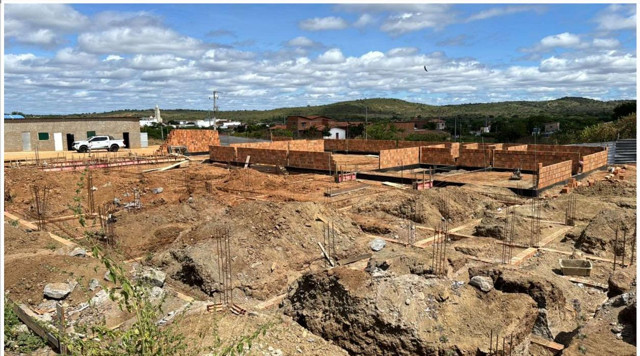
Fig. 1 – Execução de infraestrutura, superestrutura e alvenaria
