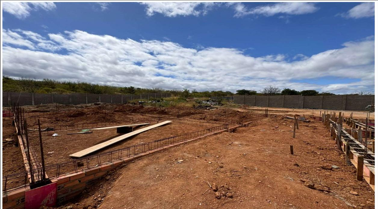
Fig. 2 – Execução de infraestrutura, superestrutura e movimento de terra
