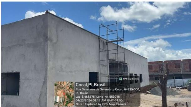
Fig. 18 – (12 revestimentos de paredes) – Reboco
