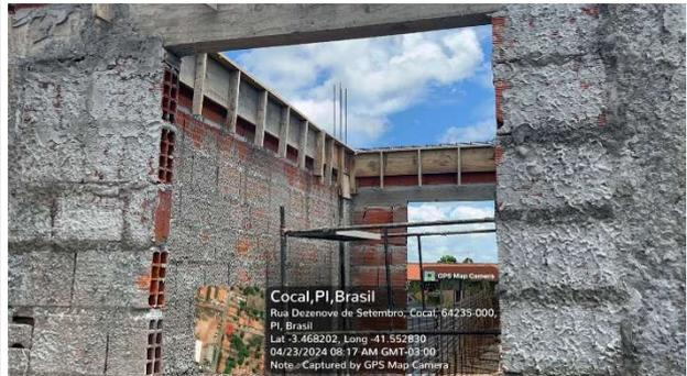
Fig. 17 – (12 revestimentos de paredes) – Reboco
