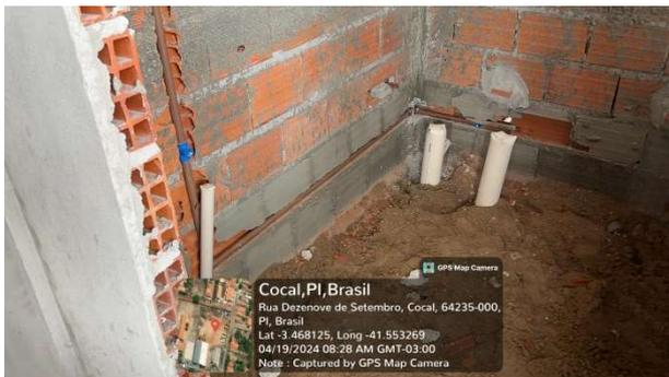
Fig. 10 - (9.0 Instalações Sanitárias) – Tubulação
