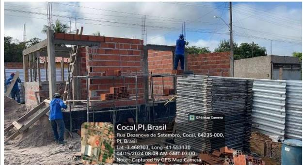
Fig. 5 – (6 Paredes de vedação) – Alvenaria
