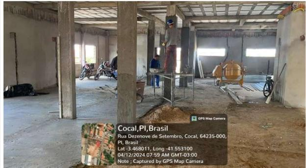
Fig. 15 – (11.1 revestimentos internos) – Contrapiso
