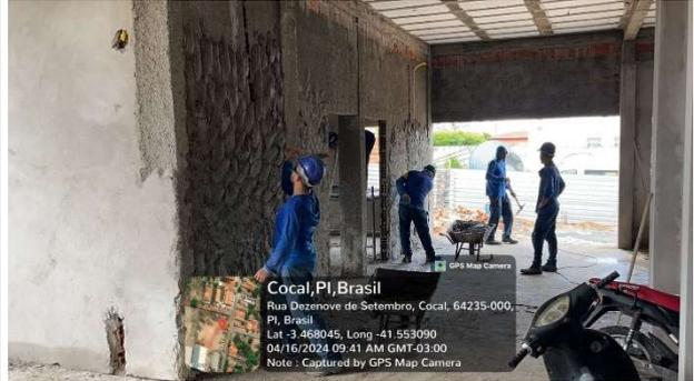
Fig. 21 - (12.0 Revestimentos de paredes) – Reboco
