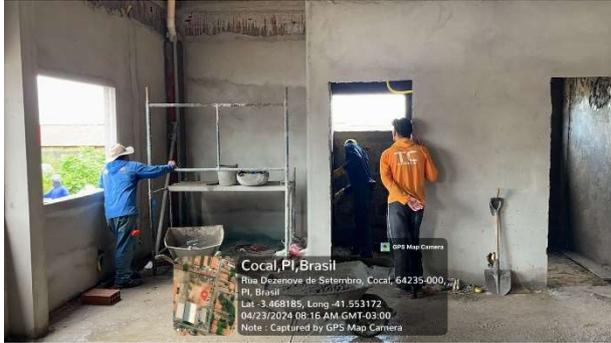
Fig. 20 – (12.0 Revestimentos de paredes) – Reboco
