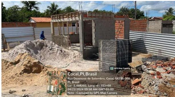
Fig. 4 – (6 Paredes de vedação) – Alvenaria
