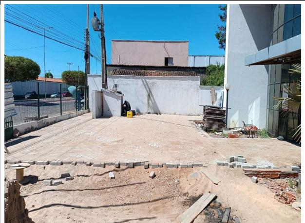
Fig. 6 – Execução de piso intertravado
