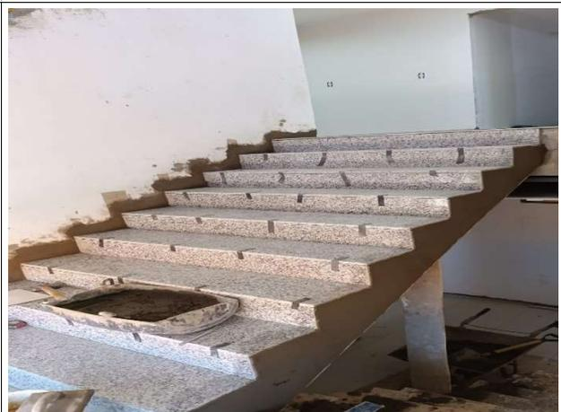
Fig. 8 – Piso de granito da escada
