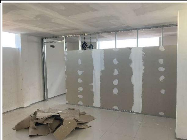
Fig. 5 – Execução de paredes de drywall
