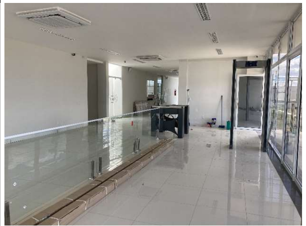
Fig. 4 – Execução de divisória de vidro e controle de acesso
