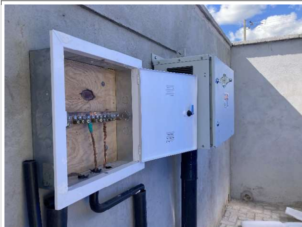
Fig. 11 – Instalações elétricas/SPDA
