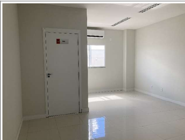
Fig. 7 – Execução de piso, pintura e forro
