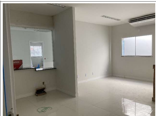
Fig. 14 – Esquadrias, pintura e instalações
