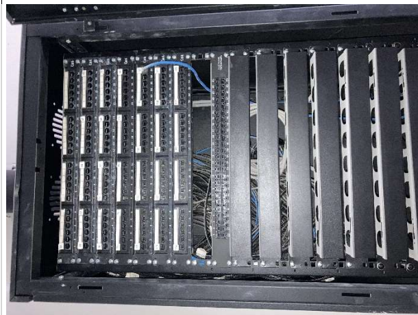
Fig. 9 – Cabeamento estruturado
