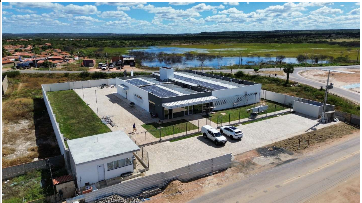
Fig. 1 – Vista aérea da obra
