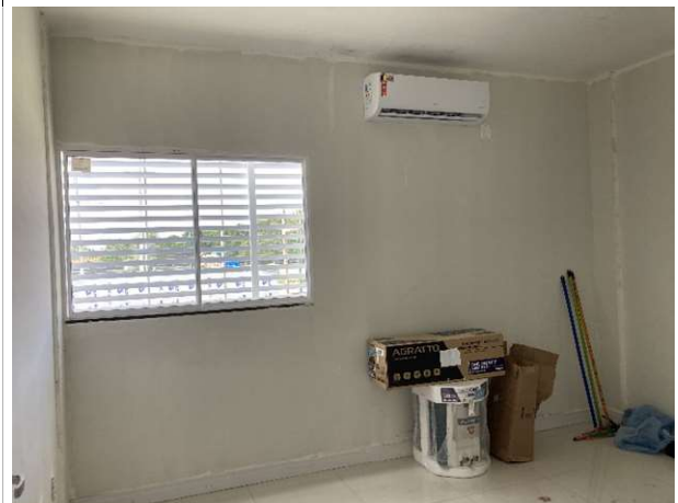
Fig. 10 – Pintura e instalações elétricas
