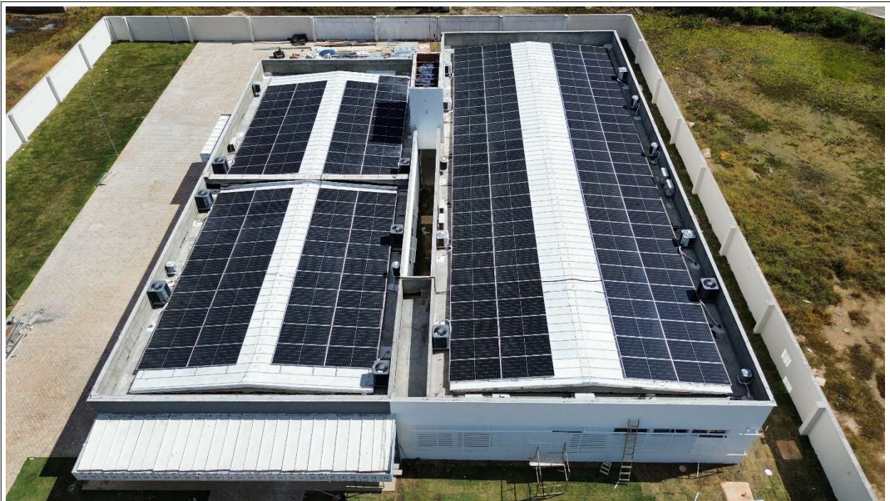
Fig. 2 – Vista aérea da obra
