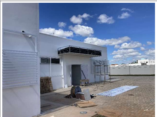
Fig. 8 – Execução de revestimento em alumínio
