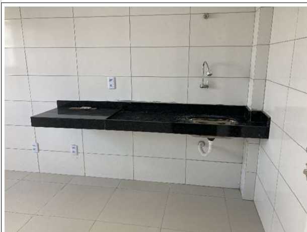
Fig. 13 – Instalações hidrossanitárias e revestimentos
