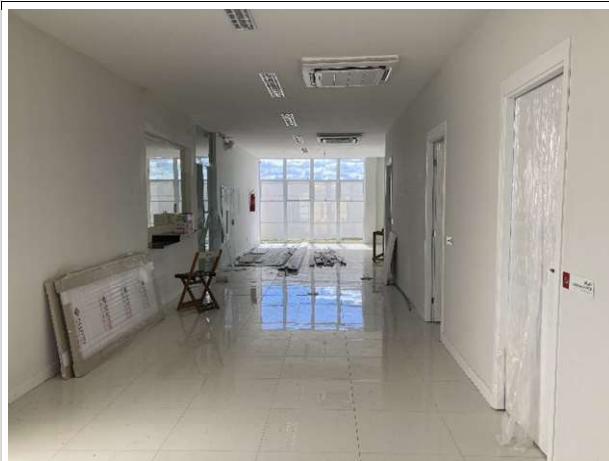
Fig. 5 – Execução de piso, pintura e esquadrias
