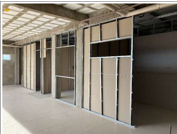
Fig. 7 – execução de piso cerâmico e paredes de drywall
