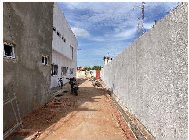
Fig. 4 – muro e calha de águas pluviais
