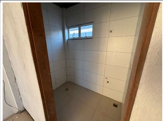
Fig. 12 – revestimentos cerâmicos de parede e piso
