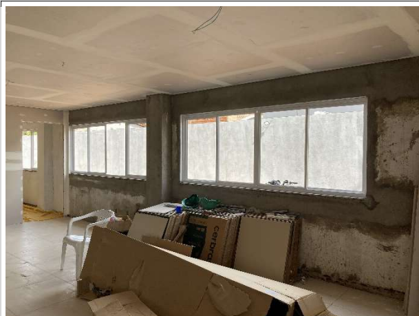
Fig. 11 – forro e esquadrias de alumínio e vidro
