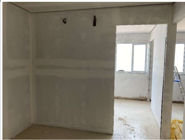
Fig. 9 – execução de piso, pinturas e paredes de drywall
