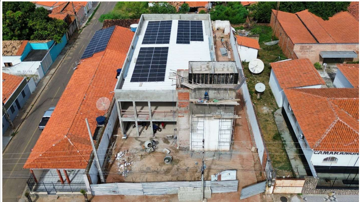
Fig. 1 – Vista aérea da obra
