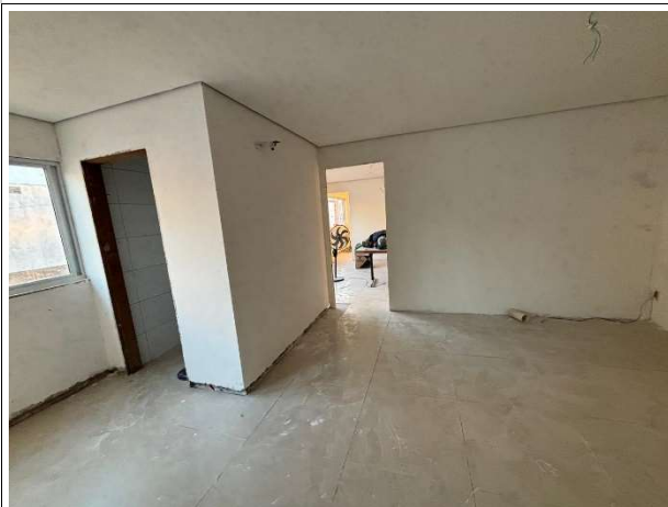
Fig. 13 – execução de pintura e piso cerâmico
