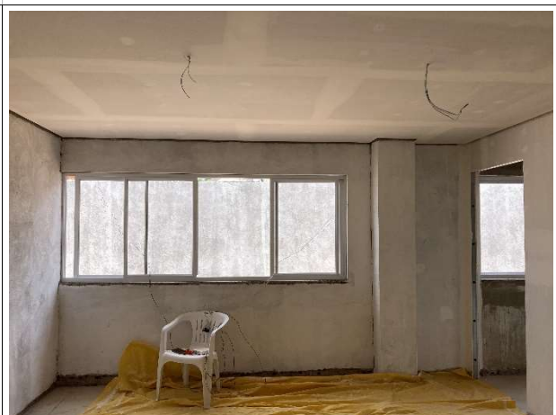
Fig. 8 – execução de instalações elétricas e forro
