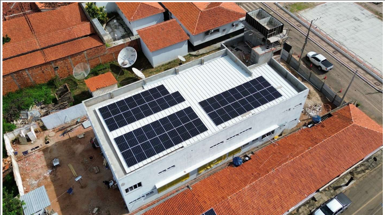
Fig. 2 – Vista aérea da obra
