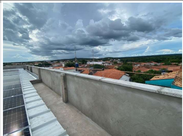
Fig. 6 – execução de SPDA e cobertura
