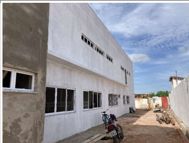
Fig. 5 – execução de pinturas e esquadrias
