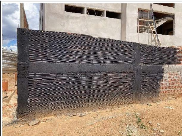
Fig. 13 – Execução de impermeabilização de baldrame
