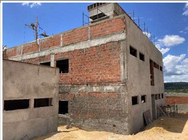
Fig. 5 – Execução de superestrutura e alvenaria
