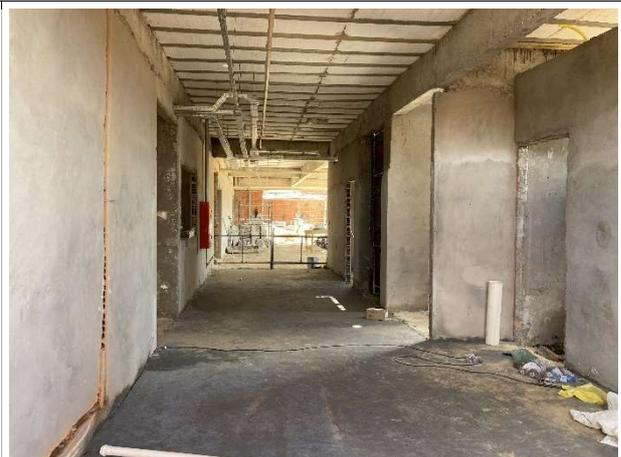
Fig. 6 – Execução de contrapiso, revestimentos e alvenaria
