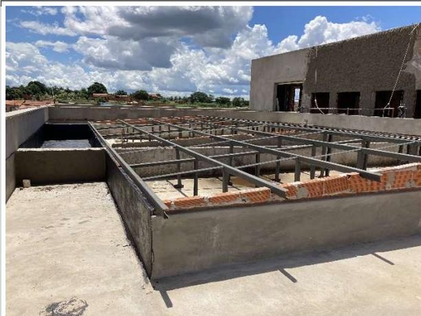
Fig. 11 – Execução de estrutura metálica da cobertura
