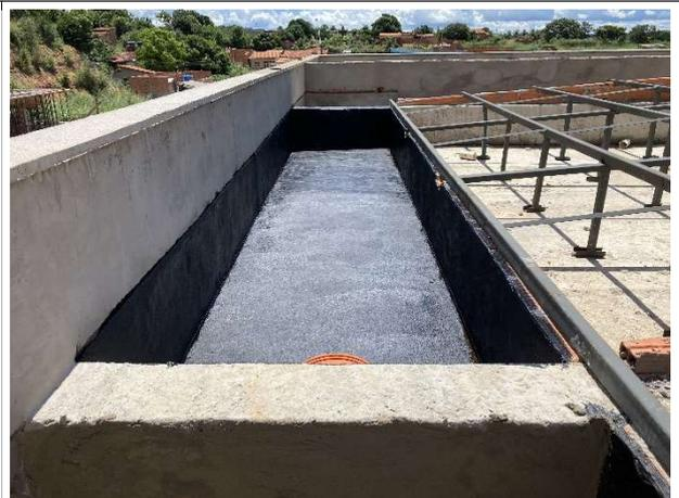
Fig. 12 – Execução de impermeabilização de laje
