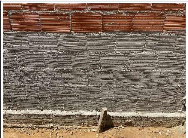
Fig. 14 – Aplicação de argamassa impermeabilizante
