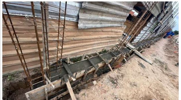
Fig. 16 - (3.0 Construção de Muro) - concretagem de viga e armação de pilares
