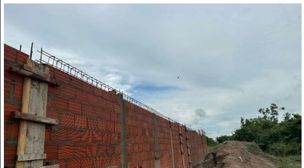
Fig. 18 - (4.0 Paredes e Paineis) – Alvenaria de Vedação
