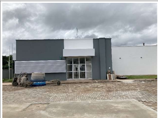
Fig. 12 – fachada lateral do Fórum
