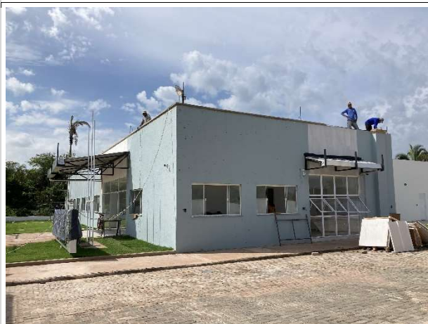
Fig. 5 – execução de pintura da fachada lateral
