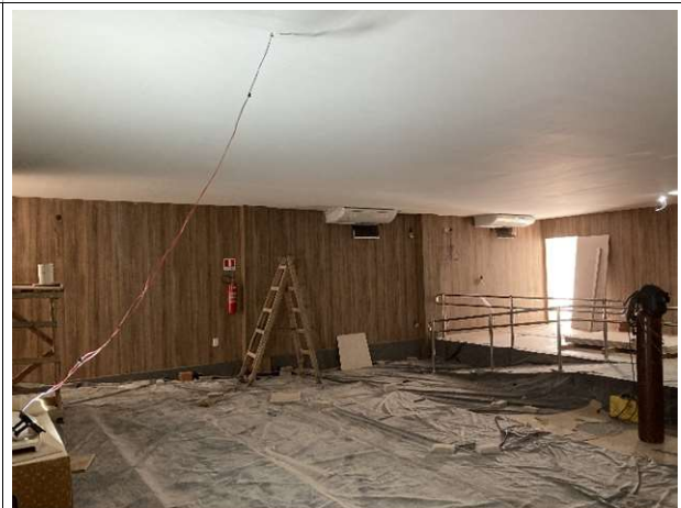
Fig. 8 – execução de revestimentos e climatização
