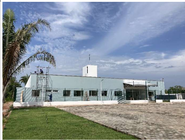
Fig. 3 – pavimentação, pintura e serviços complementares
