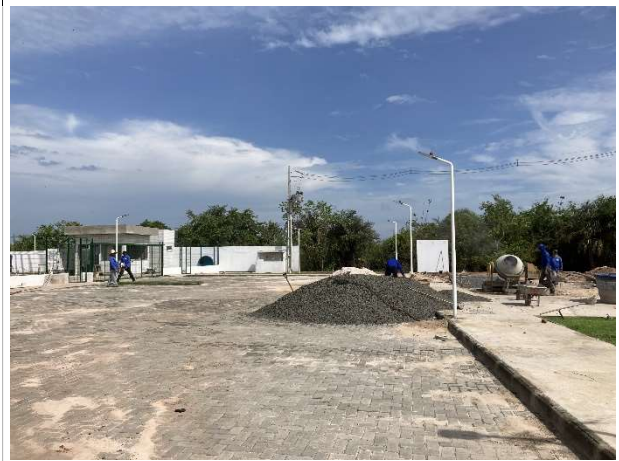
Fig. 4 – pavimentação e iluminação externa
