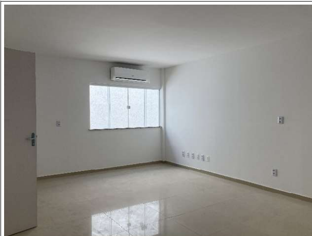
Fig. 7 – esquadrias e instalações elétricas/climatização
