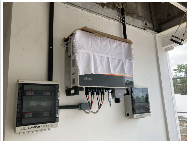
Fig. 9 – inversor fotovoltaico
