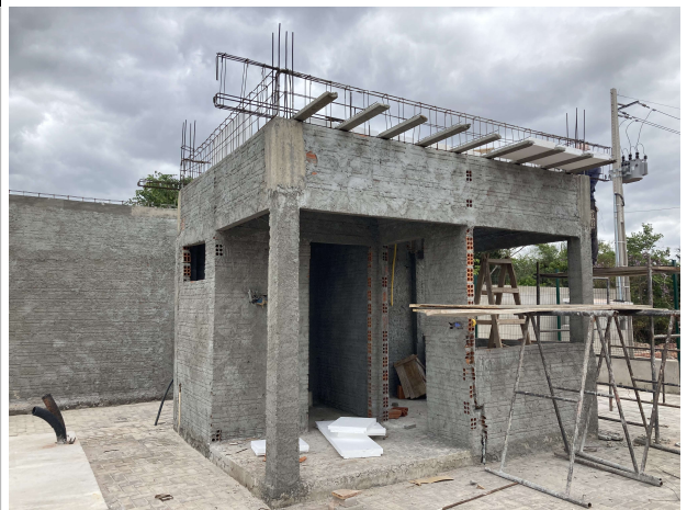
Fig. 4 – construção da guarita
