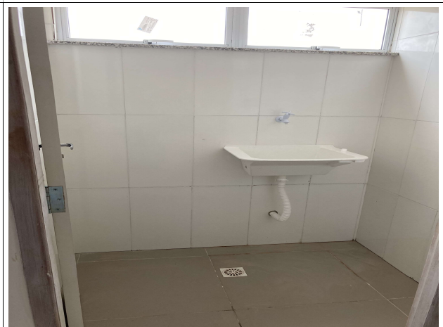
Fig. 14 – execução de revestimentos e instalações
