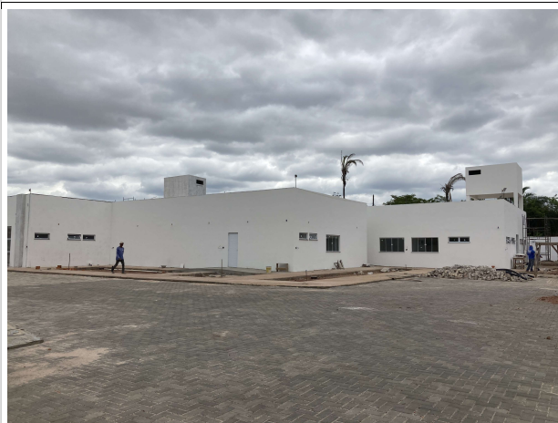
Fig. 5 – execução de pintura da fachada lateral
