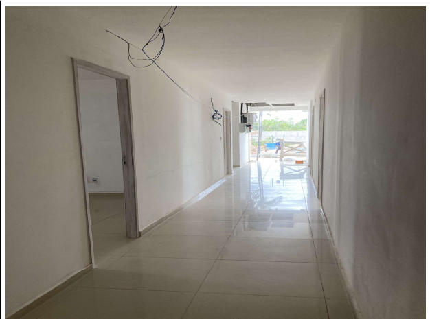
Fig. 8 – execução de pintura e parede de drywall
