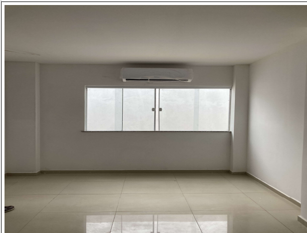
Fig. 13 – esquadrias e instalações de climatização
