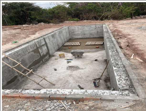
Fig. 7 – execução de cisterna
