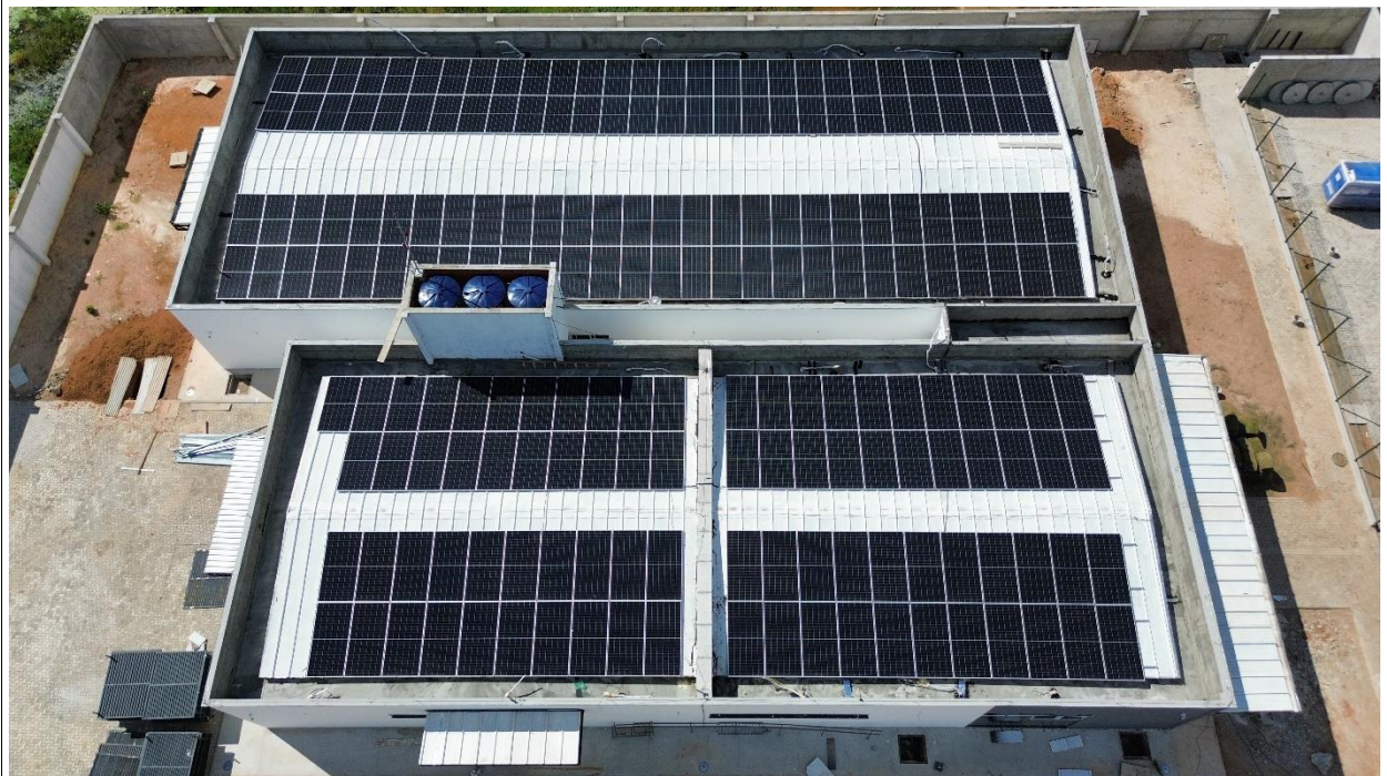
Fig. 2 – Vista aérea da obra
