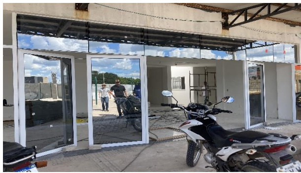
Fig. 7 - Execução de esquadrias
