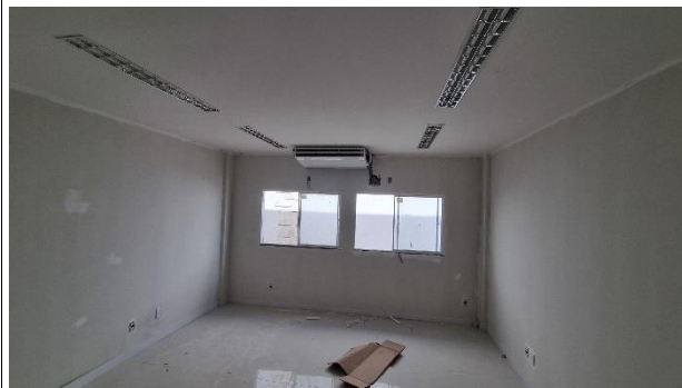
Fig. 11 – Revestimento, Instalações Elétricas
