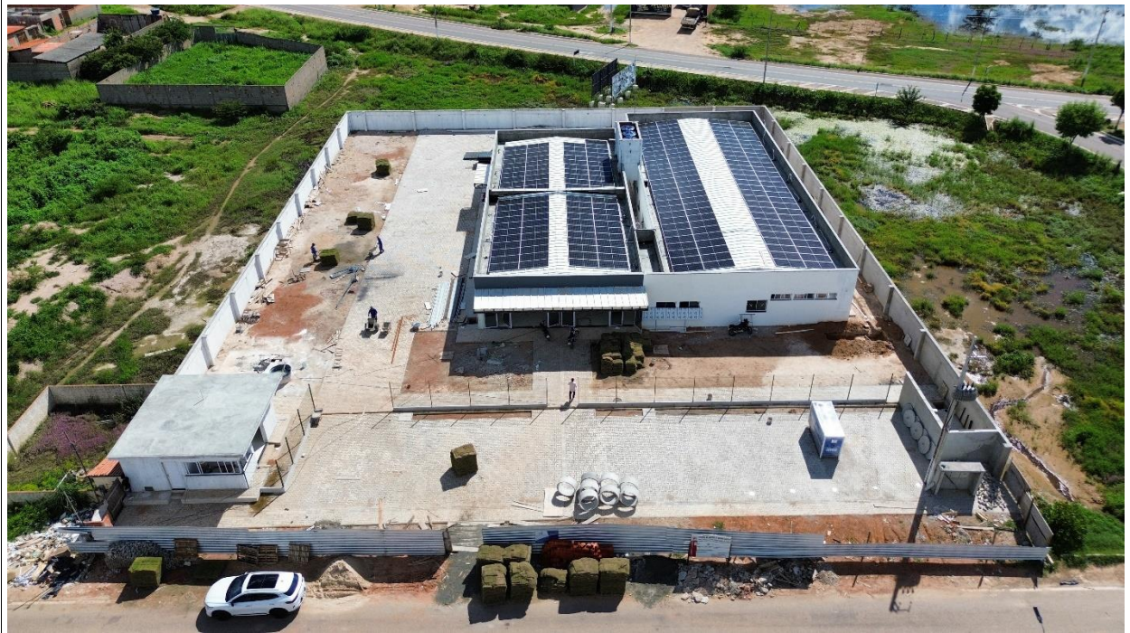
Fig. 1 – Vista aérea da obra
