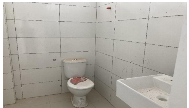
Fig. 10 - Instalações hidrossanitárias, revestimento
