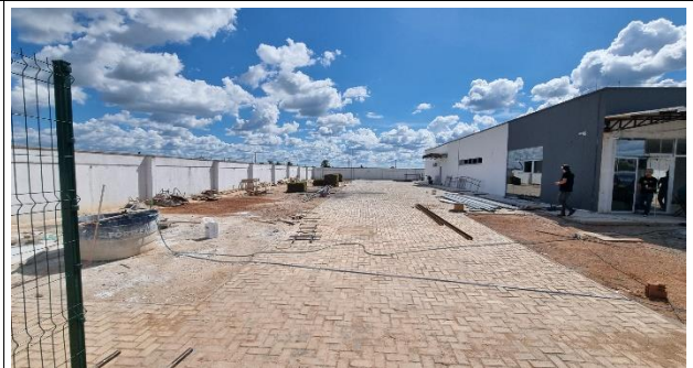
Fig. 6 - Execução de pavimento intertravado
