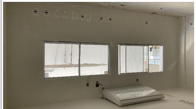
Fig. 12 – Pintura, instalações elétricas e lógicas
