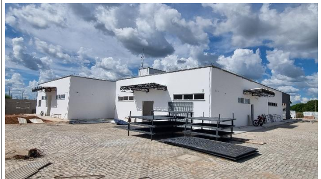
Fig. 4 - Vista lateral e fundos
