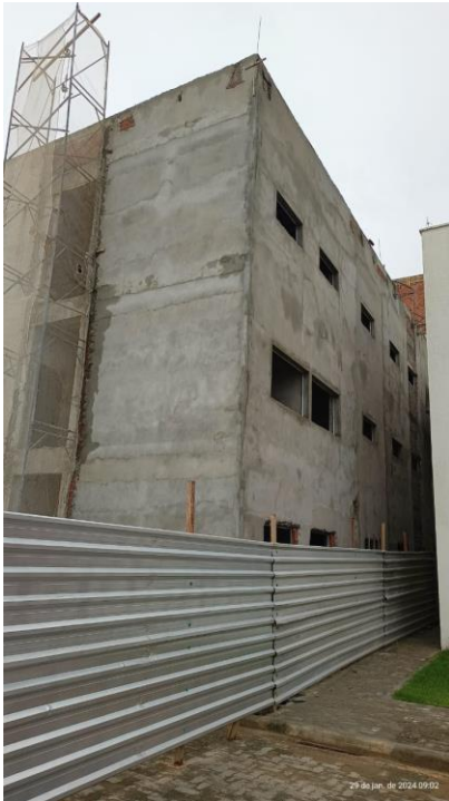
Fig. 1 – Fachada lateral da SUGESQ.
