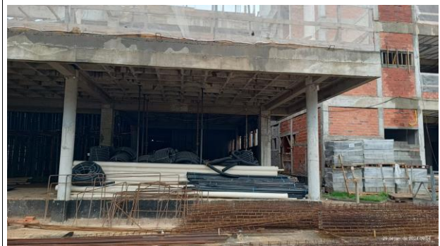
Fig. 12 – Foyer do auditório.
