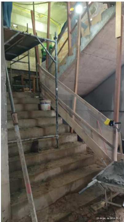
Fig. 7 – Execução da escada do auditório.
