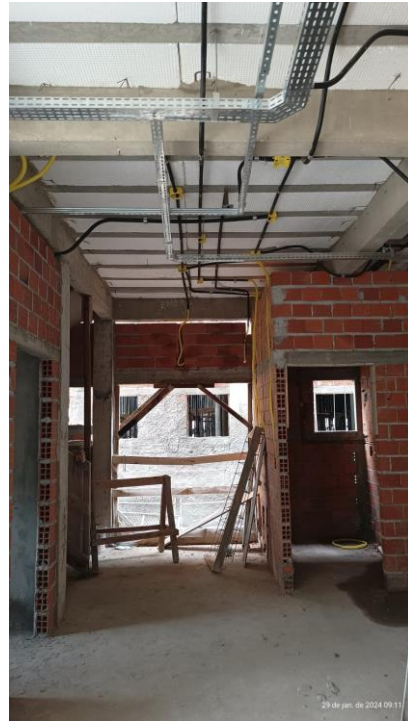
Fig. 6 – Execução de instalações e paredes.
