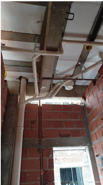
Fig. 3 – Execução de instalações hidrossanitárias.
