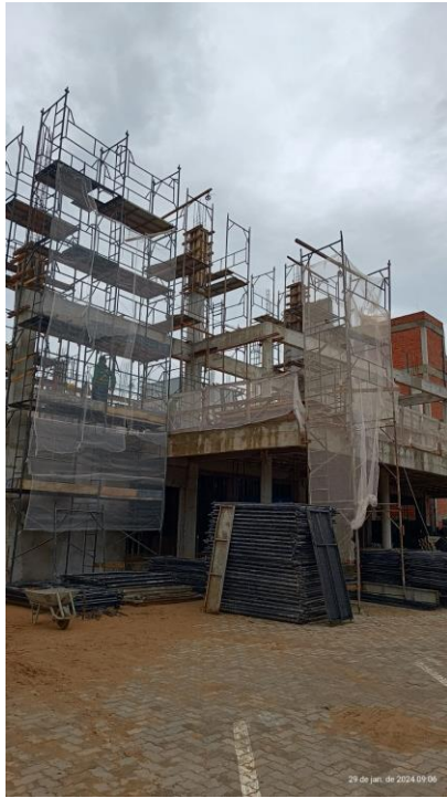
Fig. 9 – Estrutura do Auditório.
