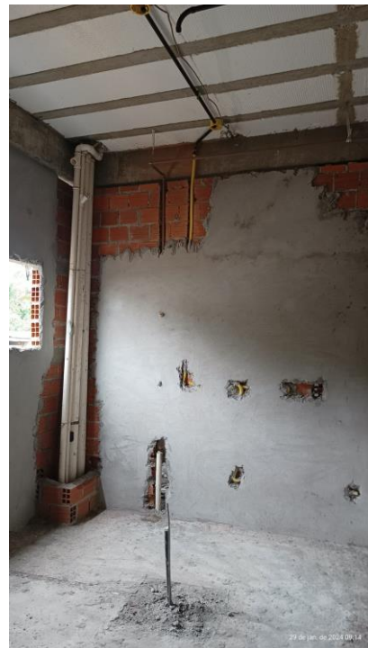
Fig. 4 – Execução de alvenaria e instalações.
