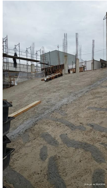
Fig. 2 – Execução de superestrutura do Auditório.
