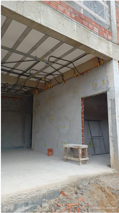
Fig. 5 – Execução de instalações elétricas.
