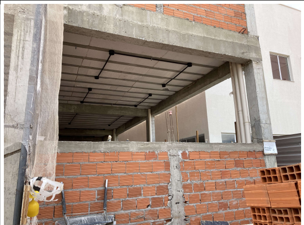
Fig. 4 – Execução de alvenaria e instalações
