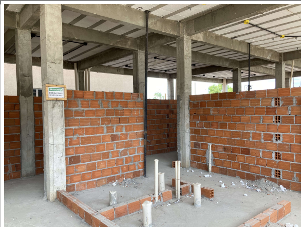
Fig. 3 – Execução de instalações hidrossanitárias
