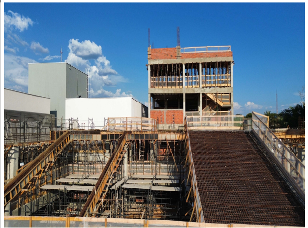
Fig. 2 – Execução de superestrutura do Auditório
