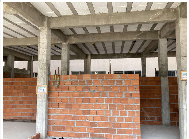
Fig. 10 – Execução de alvenaria, contrapiso e estrutura
