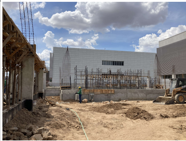
Fig. 7 – Execução de estrutura do Auditório
