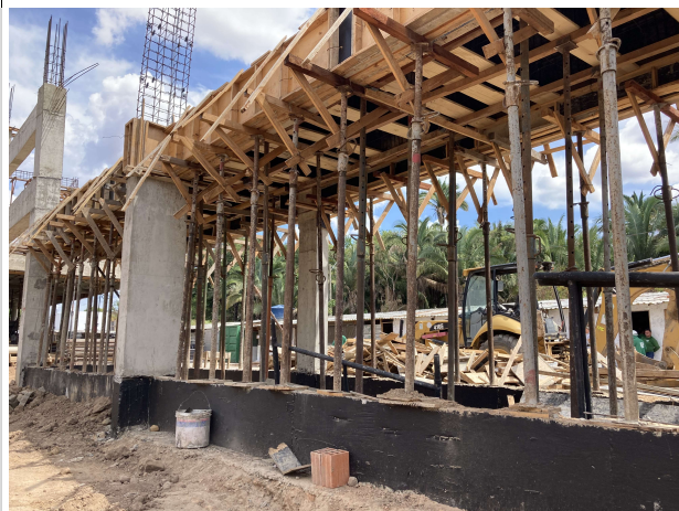
Fig. 9 – Execução de estrutura do Auditório
