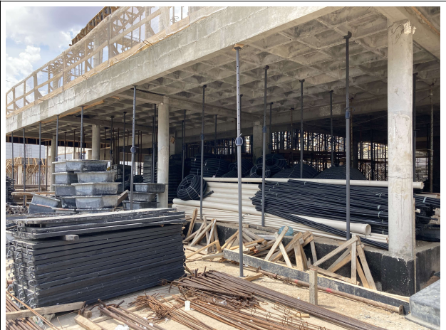
Fig. 6 – Execução de instalações e estrutura
