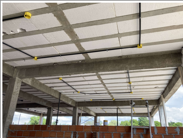
Fig. 5 – Execução de instalações elétricas
