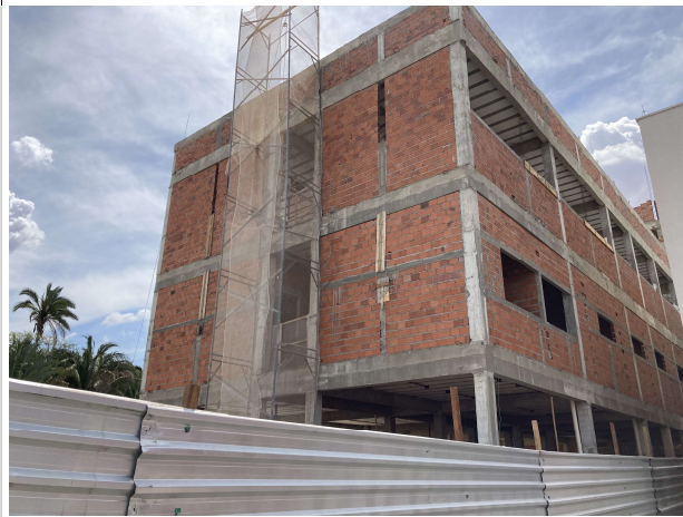
Fig. 1 – Fachada lateral da SUGESQ
