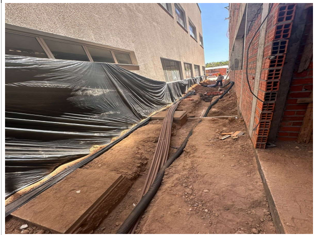
Fig. 8 – Execução de instalações hidrossanitárias
