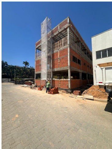
Fig. 1 – Execução de superestrutura e vedação em alvenaria da SUGESQ
