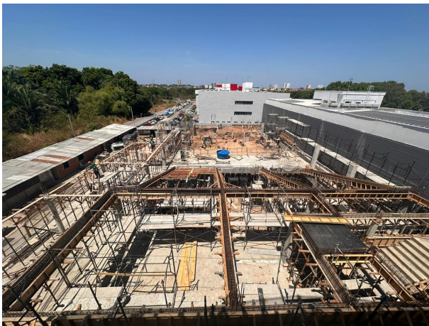
Fig. 9 – Concretagem e armação de ferragem do Auditório
