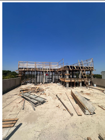
Fig. 6 – Execução caixa de água SUGESQ
