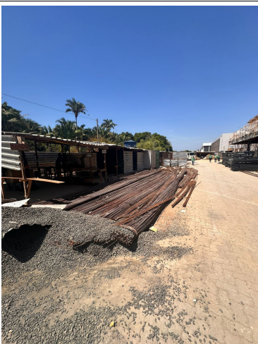
Fig. 5 – Ferragens da estrutura do Auditório
