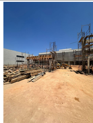
Fig. 12 – Concretagem e armação de ferragem do Auditório
