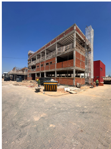
Fig. 2 – Execução de superestrutura e vedação em alvenaria da SUGESQ
