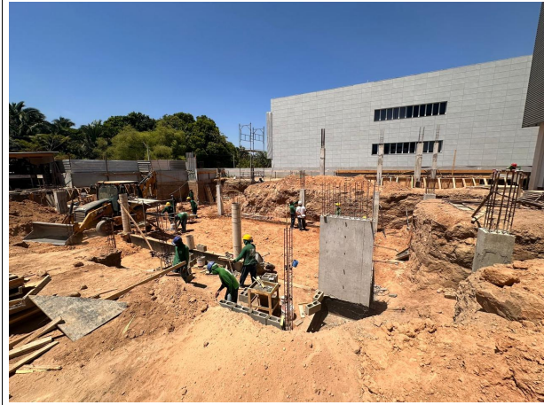
Fig. 14 – Concretagem e armação de ferragem do Auditório
