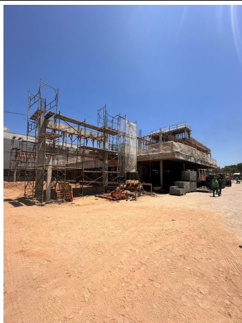
Fig. 11 – Concretagem e armação de ferragem do Auditório
