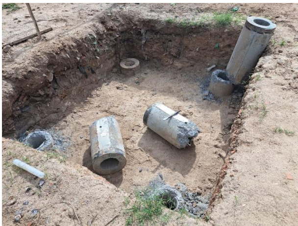
Fig. 4 – Estacas cravadas e arrasadas para bloco
