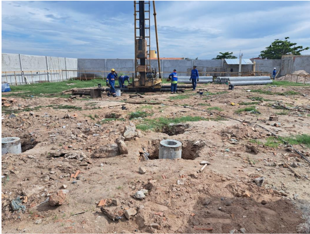
Fig. 1 – Operação de cravação de estacas
