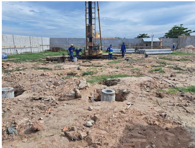
Fig. 3 – Estacas cravadas aguardando arrasamento
