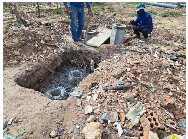
Fig. 5 – Estacas cravadas e arrasadas para bloco
