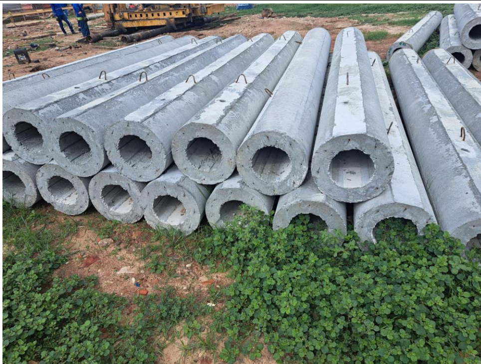
Fig. 2 – Estacas circulares para serem cravadas
