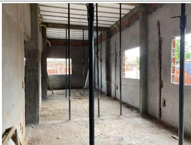
Fig. 7 – execução de superestrutura e alvenaria
