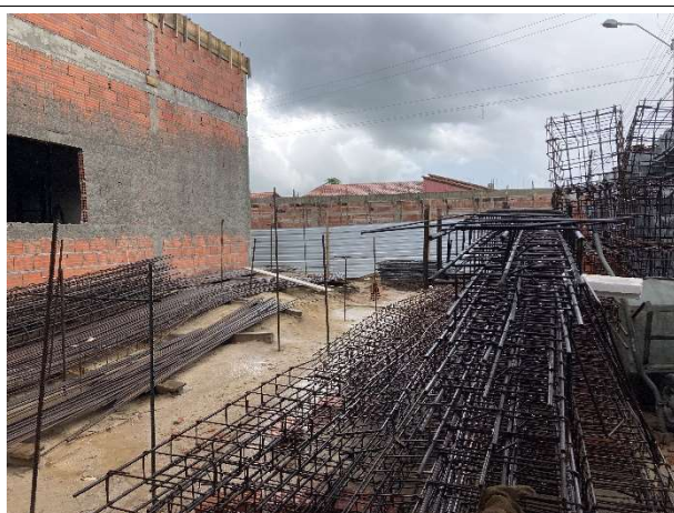
Fig. 13 – armação da estrutura do muro
