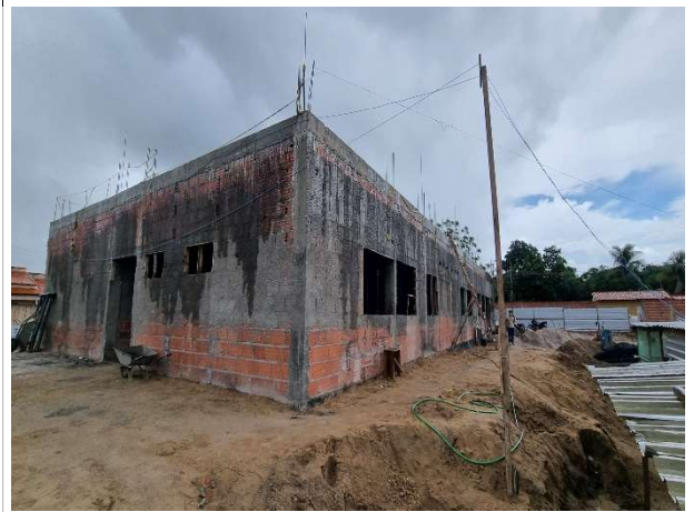
Fig. 4 – execução de movimentação de terra
