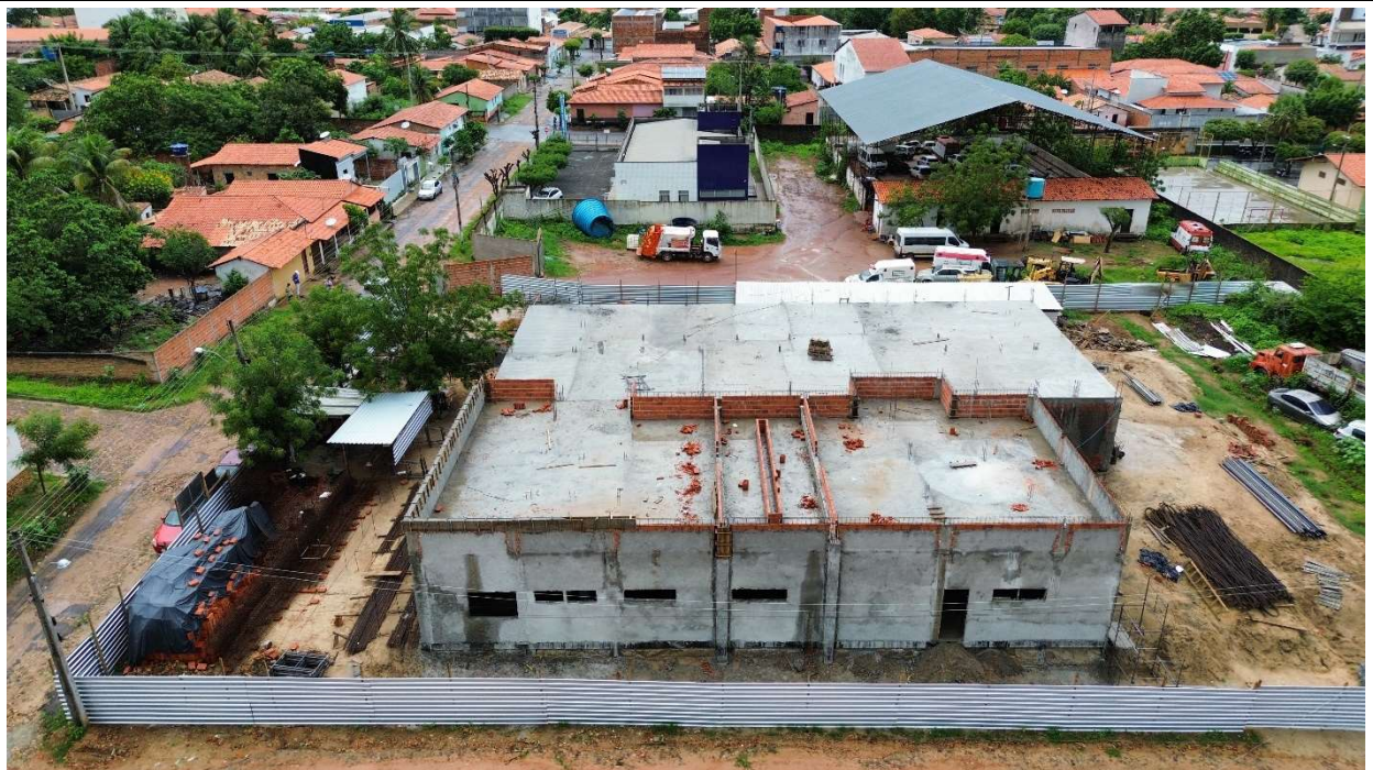
Fig. 2 – Vista aérea da obra
