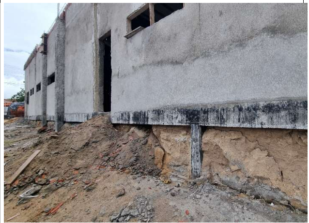
Fig. 10 – execução de impermeabilização
