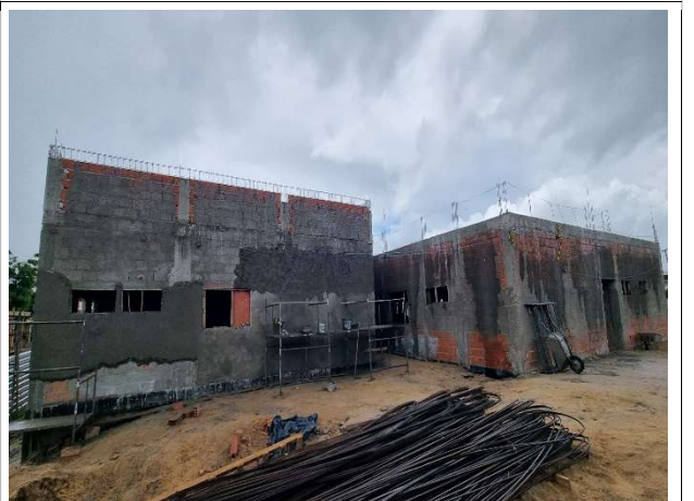
Fig. 12 – execução de infraestrutura/superestrutura
