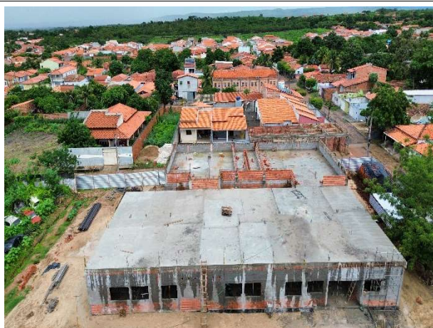
Fig. 5 – execução de infra/superestrutura
