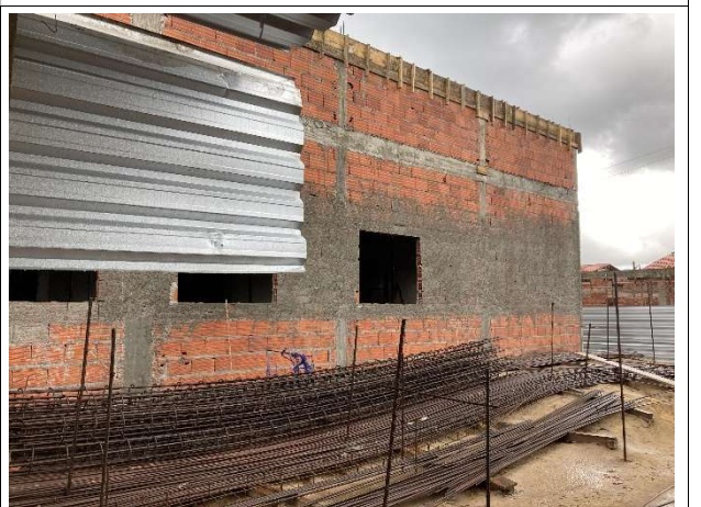
Fig. 14 – armação da estrutura do muro
