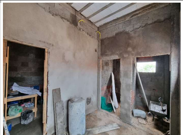
Fig. 6 – execução de alvenaria e revestimentos
