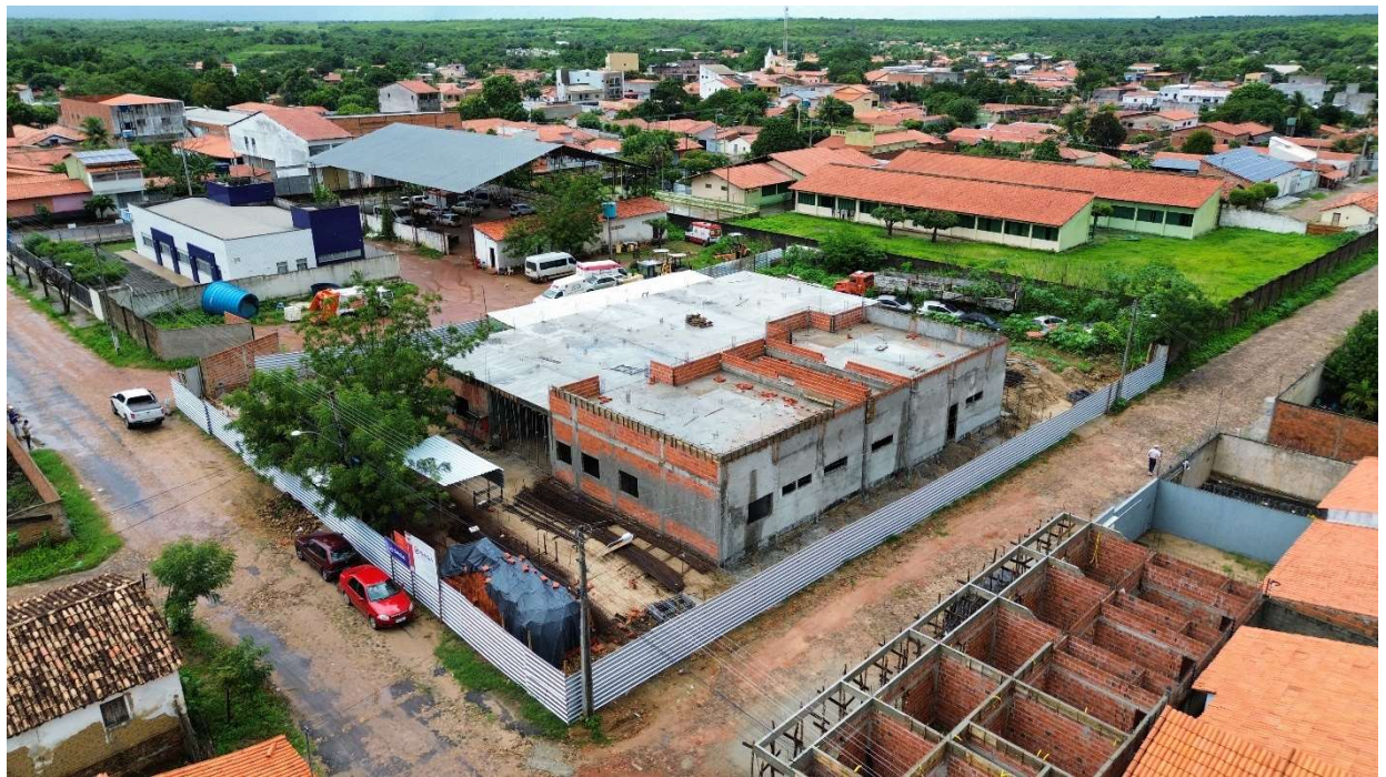
Fig. 1 – Vista aérea da obra
