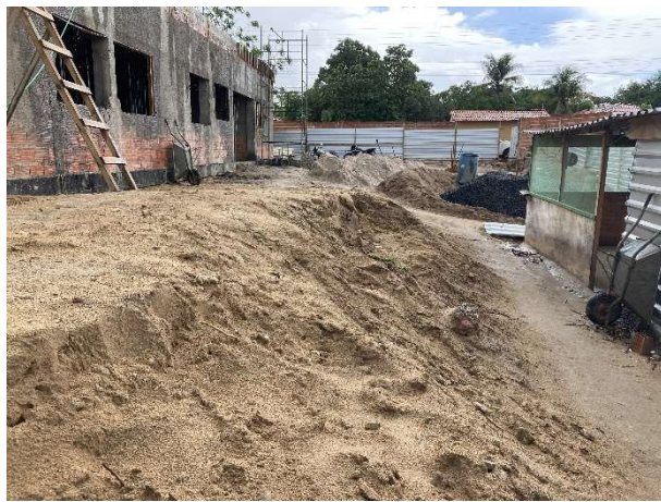
Fig. 9 – execução de movimentação de terra
