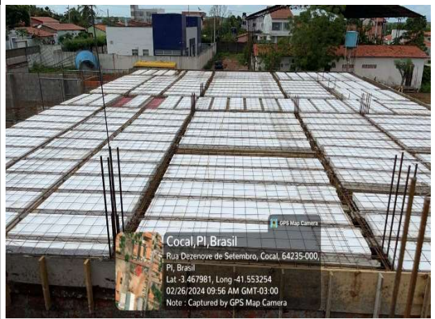
Fig. 2 – execução de estruturas de concreto
