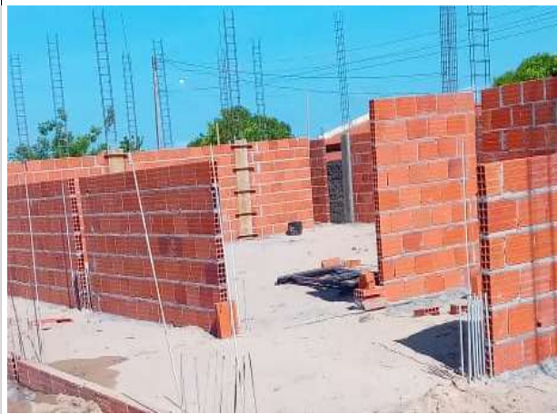
Fig. 7 – execução de alvenaria e estrutura
