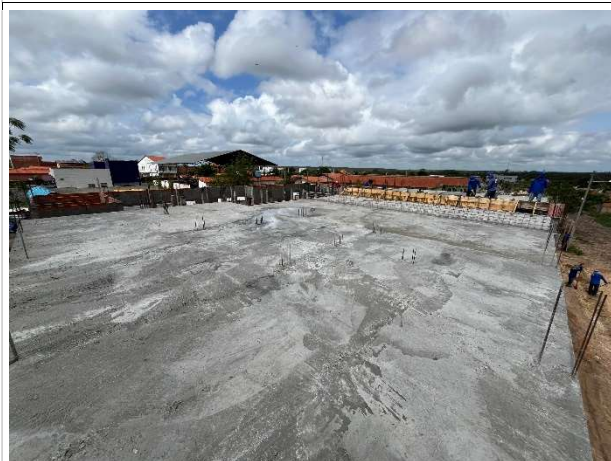
Fig. 3 – execução de estruturas de concreto
