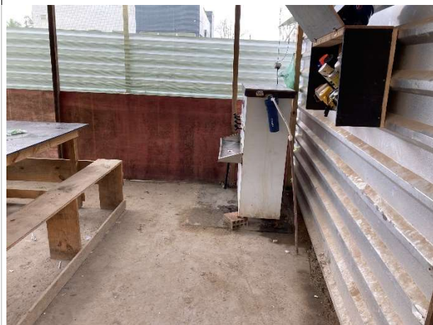
Fig. 1 – serviços preliminares (apoio do canteiro de obra)
