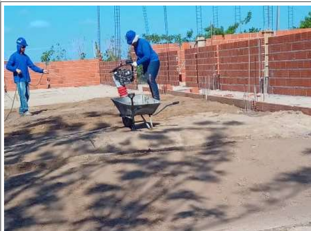
Fig. 9 – movimentação de terra, estrutura e alvenaria
