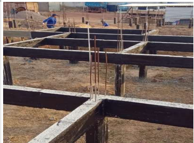
Fig. 8 – execução de impermeabilização
