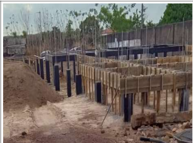
Fig. 10 – execução de infraestrutura e impermeabilização
