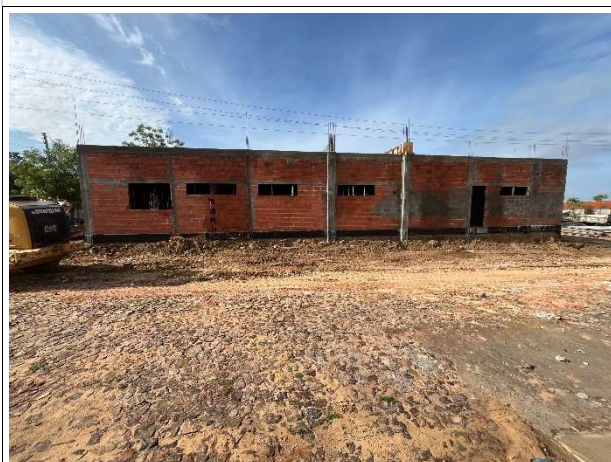
Fig. 5 – execução de alvenaria e estrutura
