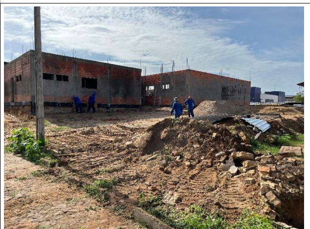
Fig. 6 – execução de estrutura e movimento de terra
