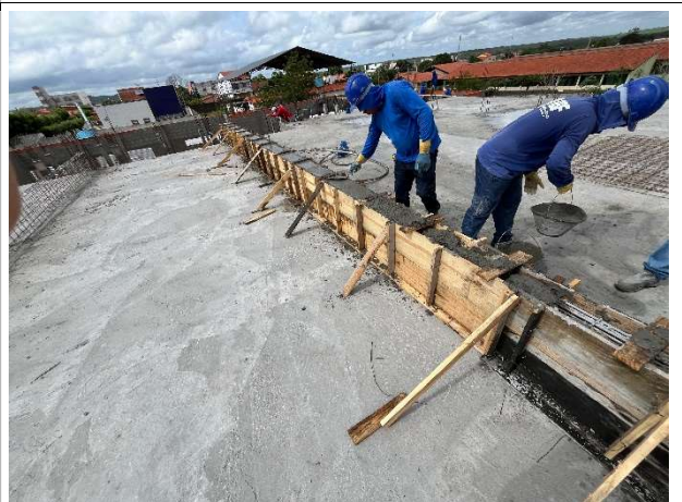
Fig. 4 – execução de estruturas de concreto
