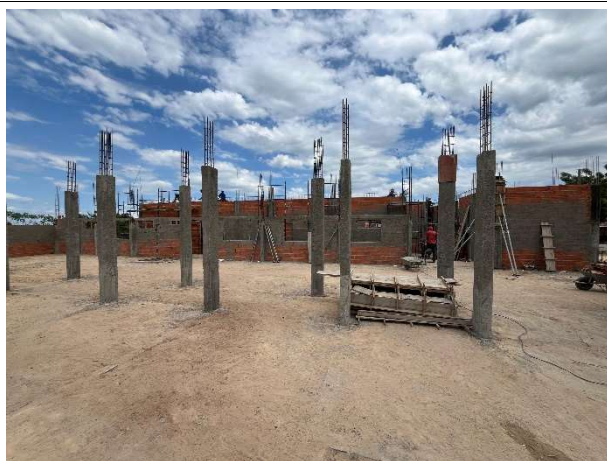
Fig. 9 – execução de estrutura e alvenaria
