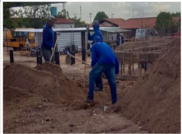
Fig. 8 – execução de movimento de terra
