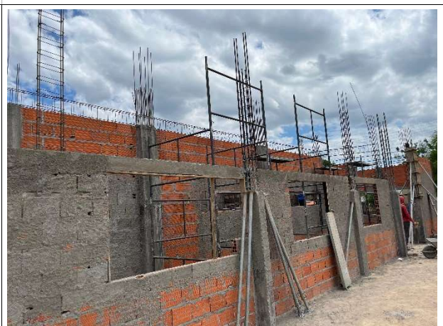
Fig. 6 – execução de estrutura e alvenaria
