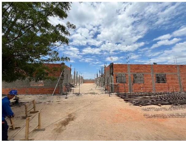
Fig. 7 – execução de infraestrutura e movimento de terra
