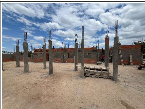
Fig. 5 – execução de infraestrutura e movimento de terra
