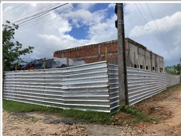
Fig. 3 – serviços preliminares (fechamento com tapumes)
