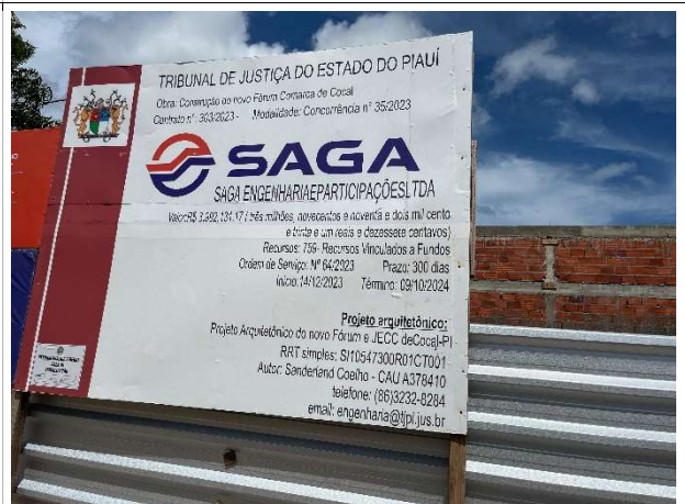
Fig. 4 – serviços preliminares (placa de obra)
