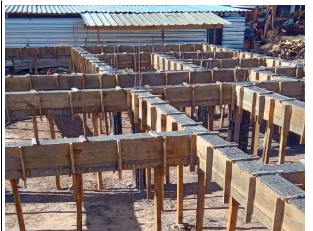
Fig. 10 – execução de infraestrutura (baldrame)
