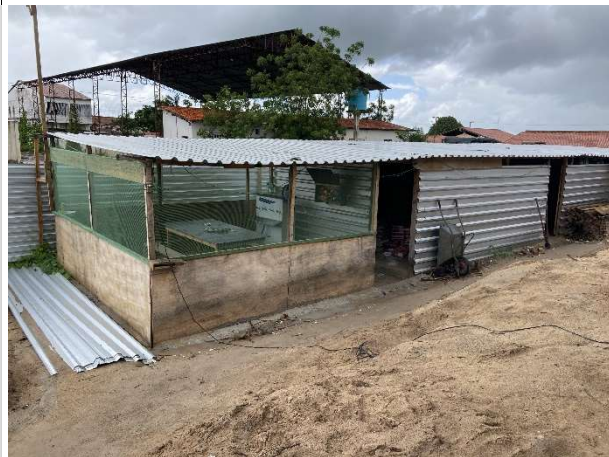
Fig. 1 – serviços preliminares (apoio do canteiro de obra)
