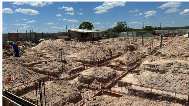
Fig. 4 – (2.0 Infraestrutura) – Armações Vigas Baldrame
