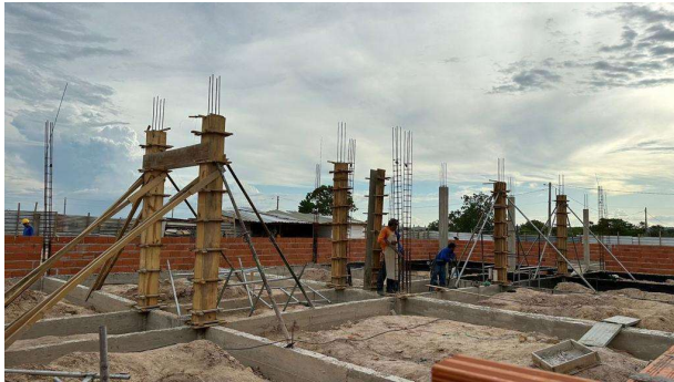
Fig. 7 – (2.0 Infraestrutura) – Armação e forma de Pilares
