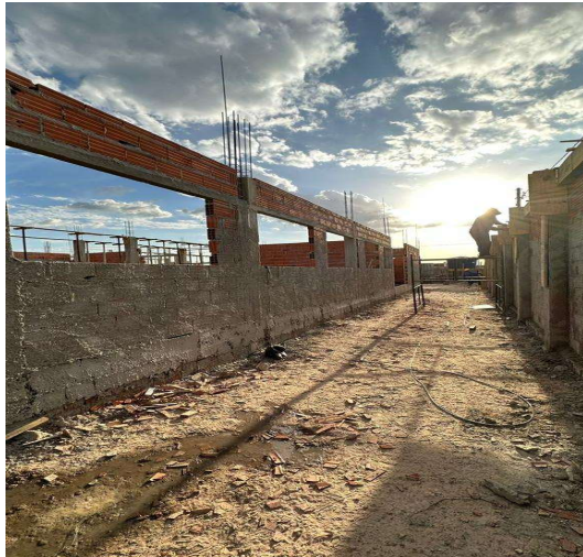
Fig. 13 – (2.0 Infraestrutura) – Verga de janelas
