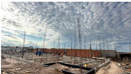
Fig. 5 – (2.0 Infraestrutura) – Vigas Baldrame
