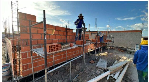
Fig. 16 – (4.0 Alvenaria) – Assentamento de Alvenaria
