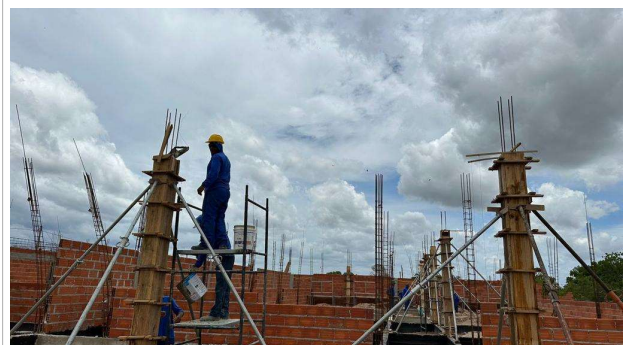
Fig. 8 – (2.0 Infraestrutura) – Armação e forma de Pilares
