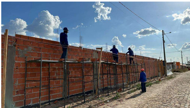
Fig. 15 – (3.0 Construção de Muro) – Muro
