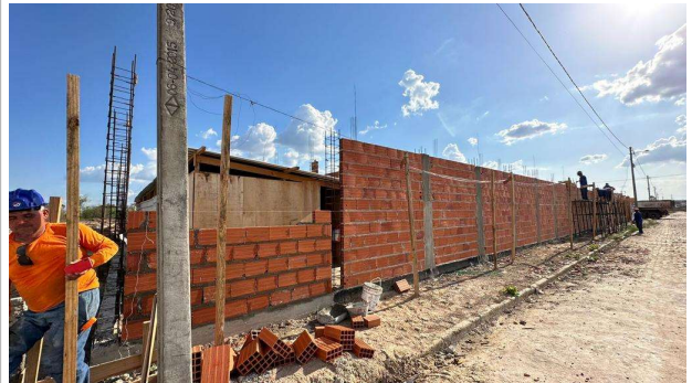
Fig. 14 – (3.0 Construção de Muro) – Muro
