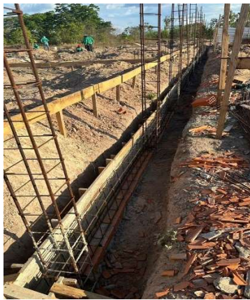
Fig. 3 – (2.0 Infraestrutura) – Armação e formas de Vigas Baldrame
