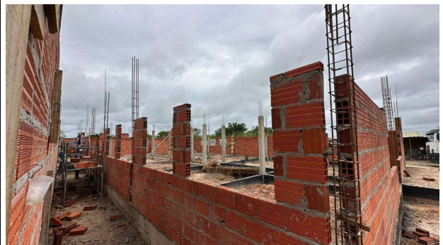
Fig. 18 – (4.0 Alvenaria) – Assentamento de Alvenaria
