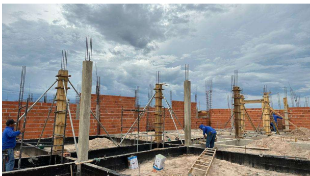
Fig. 9 – (2.0 Infraestrutura) – Forma de Pilares
