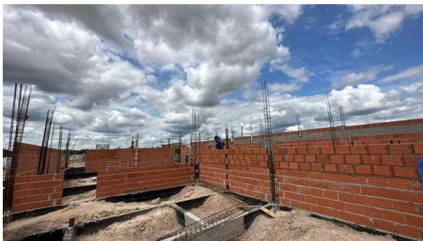
Fig. 17 – (4.0 Alvenaria) – Assentamento de Alvenaria
