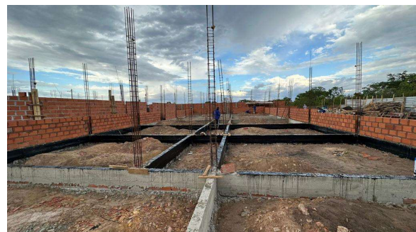
Fig. 6 – (2.0 Infraestrutura) – Vigas Baldrame
