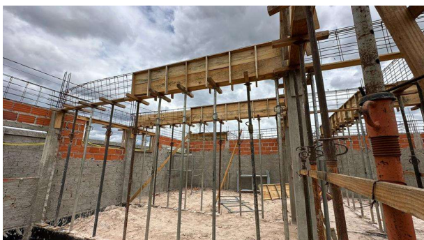
Fig. 11 – (2.0 Infraestrutura) – Armação e forma de Vigamento
