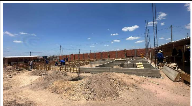
Fig. 6 – (2.0 Infraestrutura) – Formas de Vigas Baldrame
