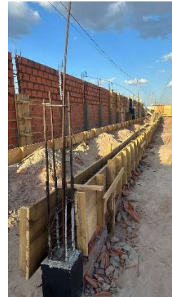
Fig. 14 – (3.0 Construção de Muro) – Execução de Alvenaria do Muro
