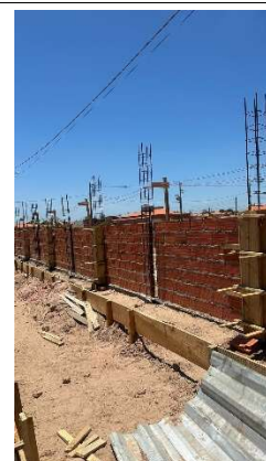
Fig. 18 (3.0 Construção de Muro) – Execução de Pilares e alvenaria do Muro
