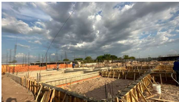
Fig. 7 - (2.0 Infraestrutura) – Concretagem de Vigas Baldrame
