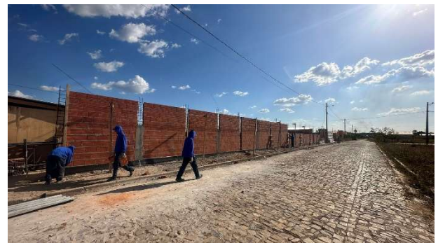
Fig. 16 (3.0 Construção de Muro) – Execução de Alvenaria do Muro
