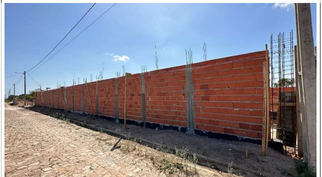
Fig. 22 – (4.0 Paredes e Painéis) – Execução de Muro
