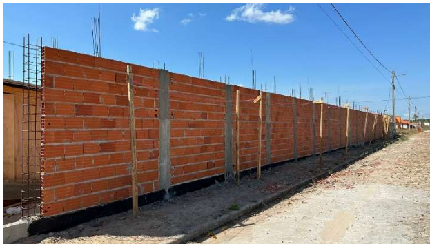
Fig. 21 – (4.0 Paredes e Painéis) – Execução de Muro
