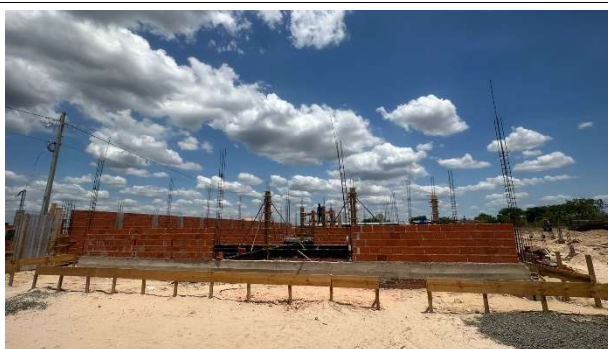
Fig. 11 (2.0 Infraestrutura) – Execução de Pilares da edificação
