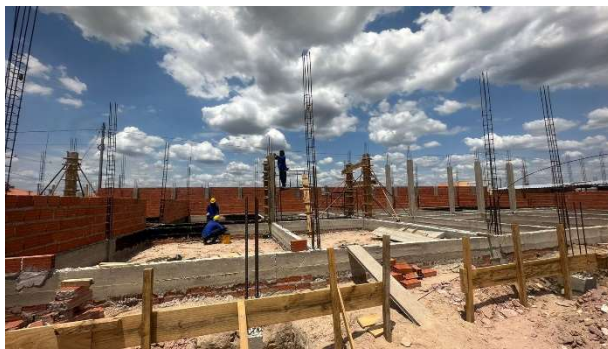
Fig. 9 – (2.0 Infraestrutura) – Impermeabilização de superfície com emulsão asfáltica
