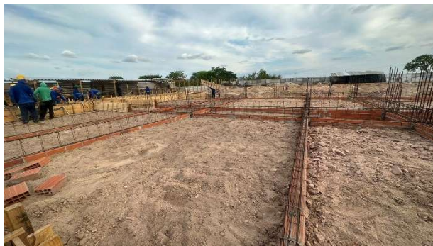
Fig. 1 – (2.0 Infraestrutura) – Armação Vigas Baldrame
