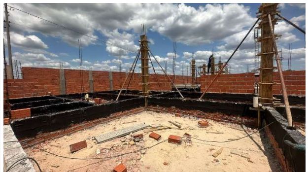
Fig. 10 (2.0 Infraestrutura) – Impermeabilização de superfície com emulsão asfáltica
