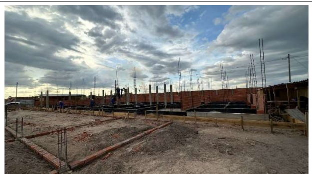
Fig. 12 (2.0 Infraestrutura) – Execução de Pilares da edificação
