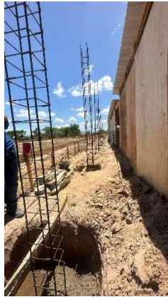
Fig. 13 – (3.0 Construção de Muro) – Execução de Armação dos Pilares do Muro
