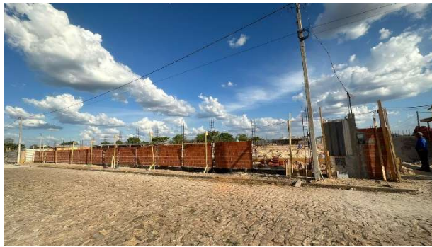
Fig. 19 – (3.0 Construção de Muro) –Execução de Muro
