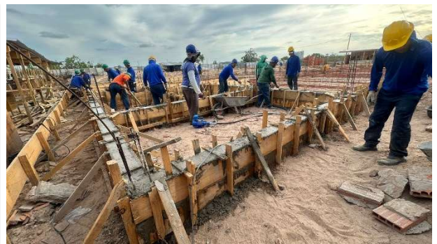
Fig. 8 – (2.0 Infraestrutura) – Concretagem de Vigas Baldrame
