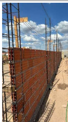
Fig. 17 (3.0 Construção de Muro) – Execução de Pilares e alvenaria do Muro
