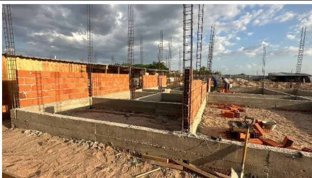
Fig. 23 – (4.0 Paredes e Painéis) – Execução de Alvenaria de Vedação
