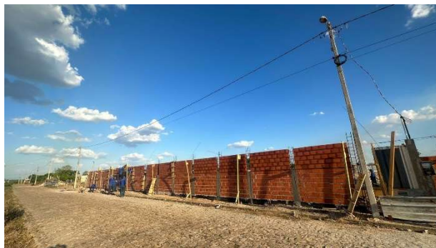
Fig. 15 – (3.0 Construção de Muro) – Execução de Alvenaria do Muro
