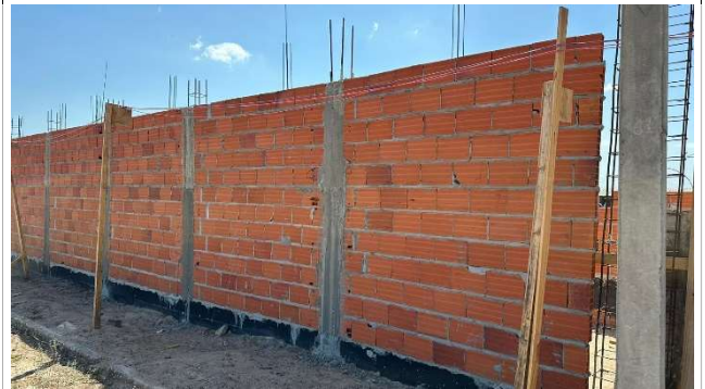
Fig. 20 – (4.0 Paredes e Painéis) – Execução de Muro
