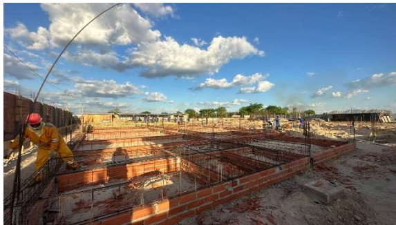
Fig. 3 – (2.0 Infraestrutura) – Armação Vigas Baldrame
