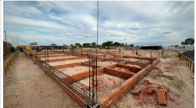
Fig. 4 – (2.0 Infraestrutura) – Armação e Formas de Vigas Baldrame
