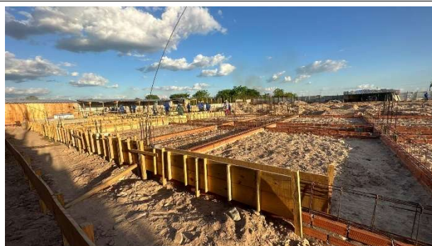
Fig. 5 – (2.0 Infraestrutura) – Armação e Formas de Vigas Baldrame
