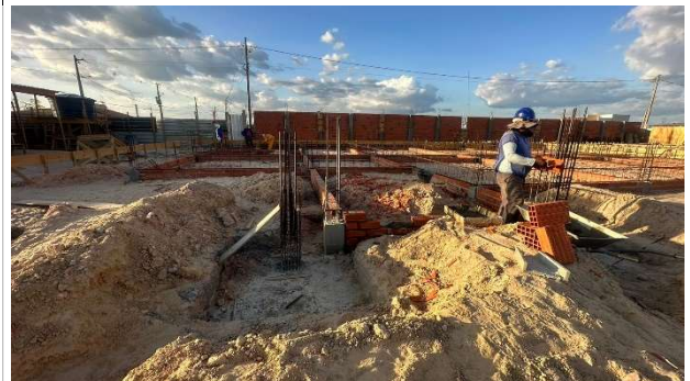
Fig. 2 – (2.0 Infraestrutura) – Armação Vigas Baldrame
