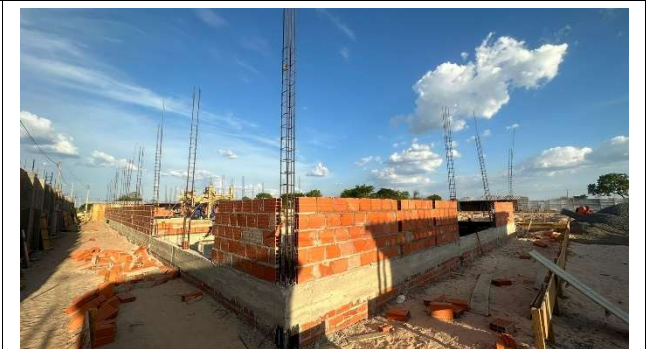
Fig. 24 – (4.0 Paredes e Painéis) – Execução de Alvenaria de Vedação
