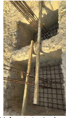
Fig. 14 – (2.0 Infraestrutura) – Armação de blocos
