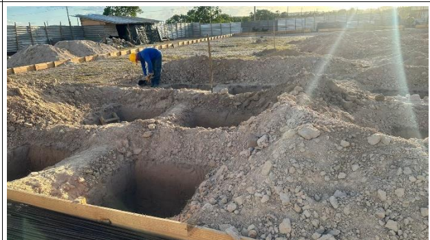
Fig. 12 (2.0 Infraestrutura) – Escavação manual para blocos
