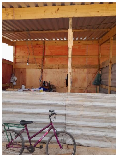
Fig. 5 – (1.0 Serviços Preliminares) – Execução de escritório em canteiro de obra
