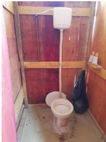
Fig. 7 – (1.0 Serviços Preliminares) – execução de sanitário em canteiro de obra
