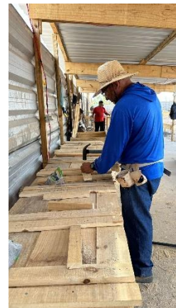
Fig. 10 (1.0 Serviços Preliminares) – Espaço para carpintaria
