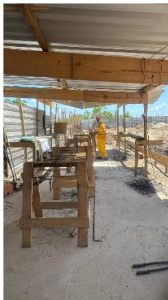
Fig. 9 – (1.0 Serviços Preliminares) – Espaço para armação da ferragem
