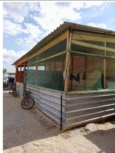
Fig. 6 – (1.0 Serviços preliminares) – Execução de refeitório em canteiro de obra
