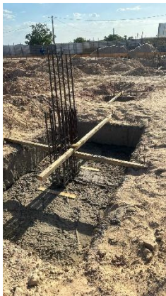
Fig. 15 – (2.0 Infraestrutura) – Concretagem de blocos
