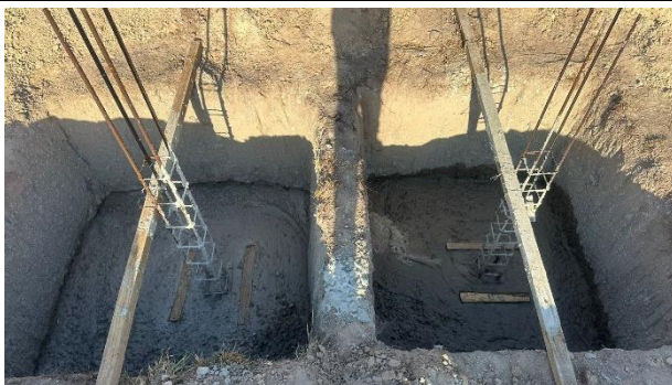
Fig. 17 (2.0 Infraestrutura) – Concretagem de blocos
