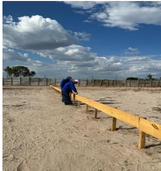
Fig. 3 – (1.0. Serviços preliminares) – Locação de obra
