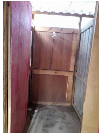
Fig. 8 – (1.0 Serviços Preliminares) – Execução de chuveiro em canteiro de obra
