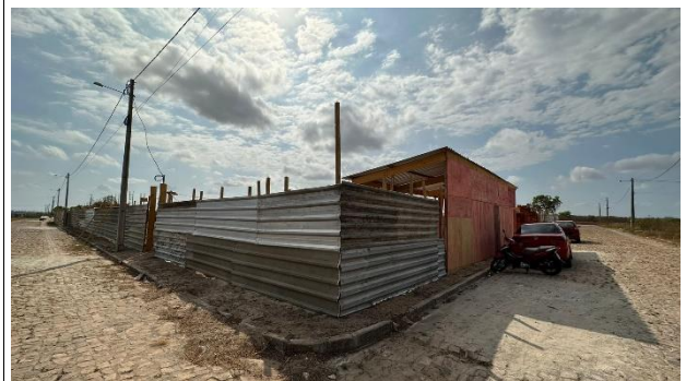
Fig. 2 – (1.0 Serviços Preliminares) - Fechamento em tapume
