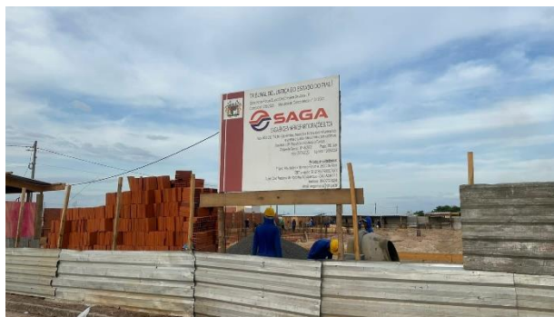
Fig. 1 – (1.0. Serviços preliminares) – Placa de obra
