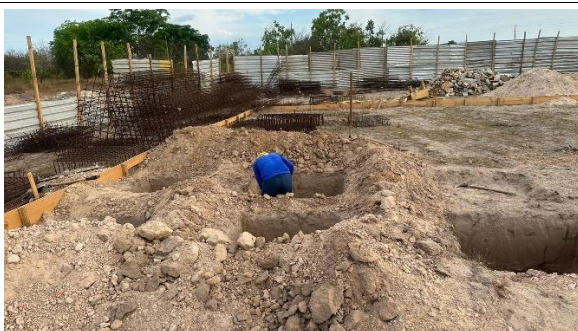
Fig. 11 (2.0 Infraestrutura) - Escavação Manual para blocos
