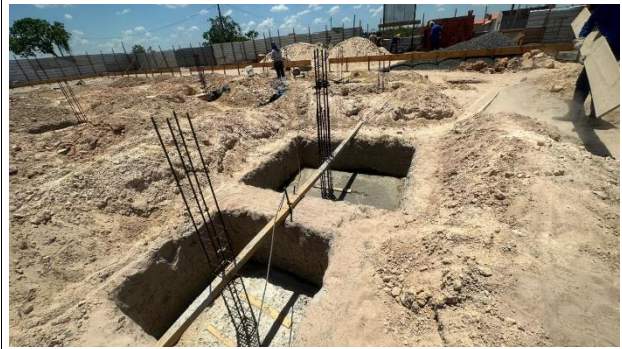
Fig. 16 (2.0 Infraestrutura) – Concretagem de blocos
