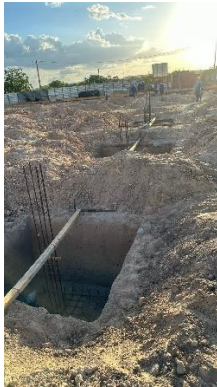
Fig. 13 – (2.0 Infraestrutura) –Armação de blocos
