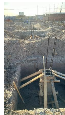
Fig. 18 (2.0 Infraestrutura) – Execução de fôrma e Concretagem de blocos
