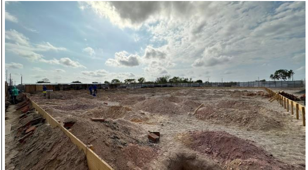
Fig. 4 – (1.0 Serviços preliminares) – Locação de obra
