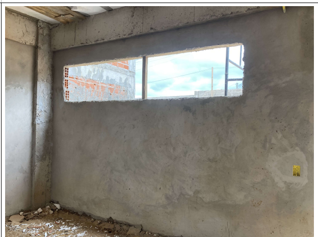
Fig. 8 – Alvenaria e revestimentos
