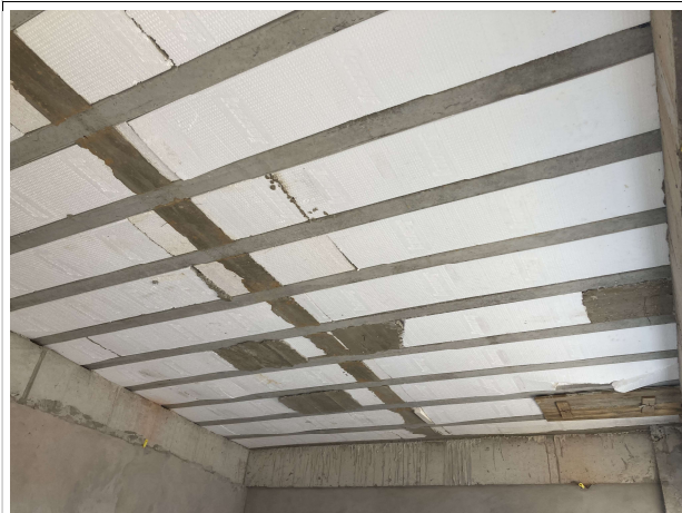
Fig. 5 – Execução de superestrutura (lajes)
