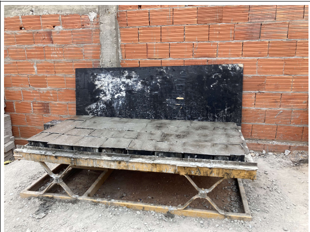
Fig. 14 – Fabricação de pavimento intertravado
