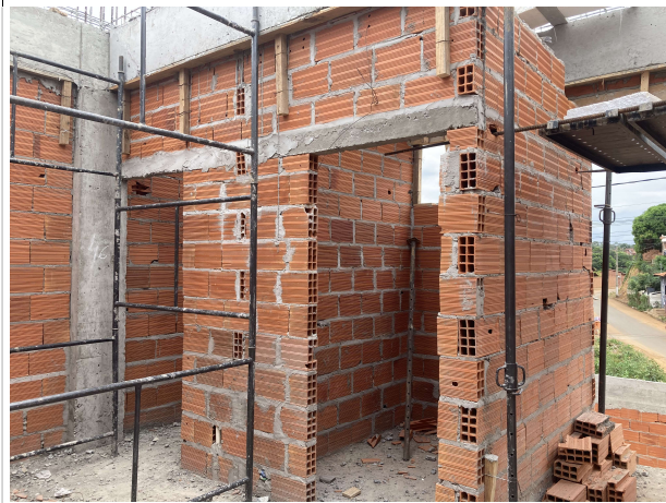
Fig. 9 – Execução de viga baldrame e alvenaria
