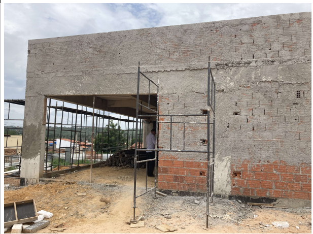
Fig. 10 – Execução de impermeabilização de viga baldrame
