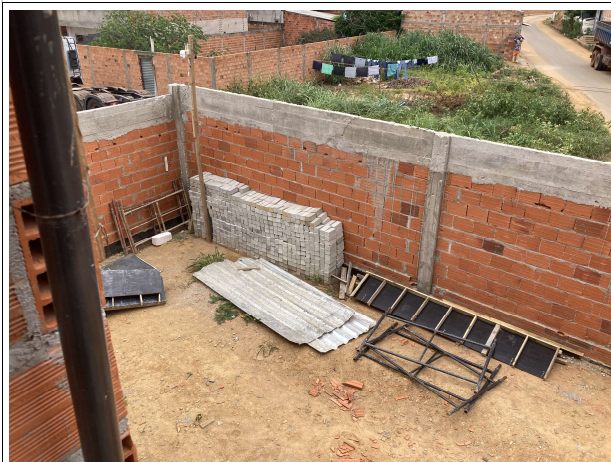
Fig. 13 – Fabricação de pavimento intertravado
