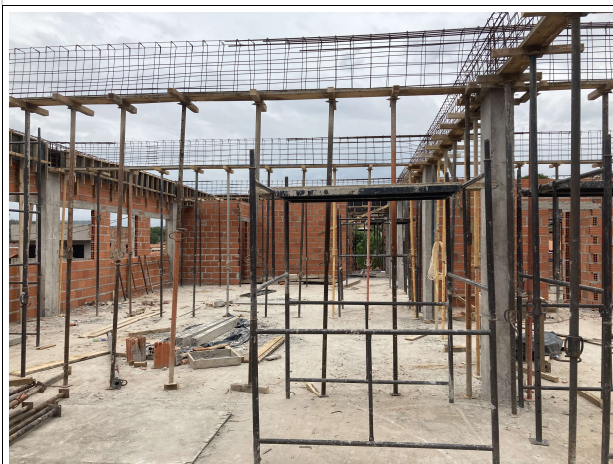
Fig. 7 – Execução de superestrutura (vigas 1º Pavimento)
