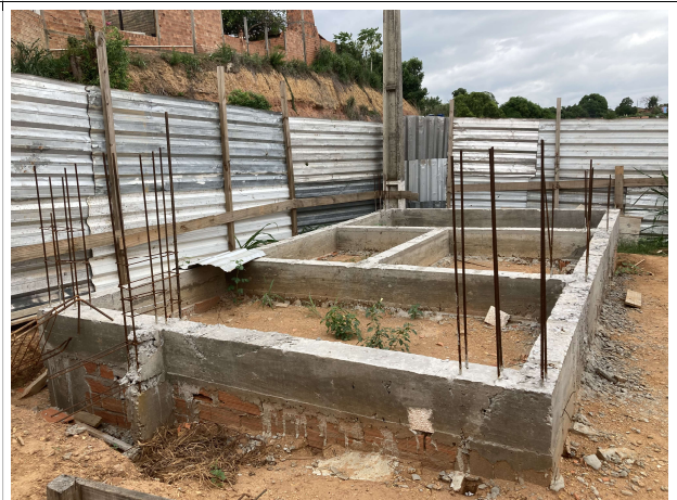
Fig. 6 – Execução de infraestrutura (guarita)
