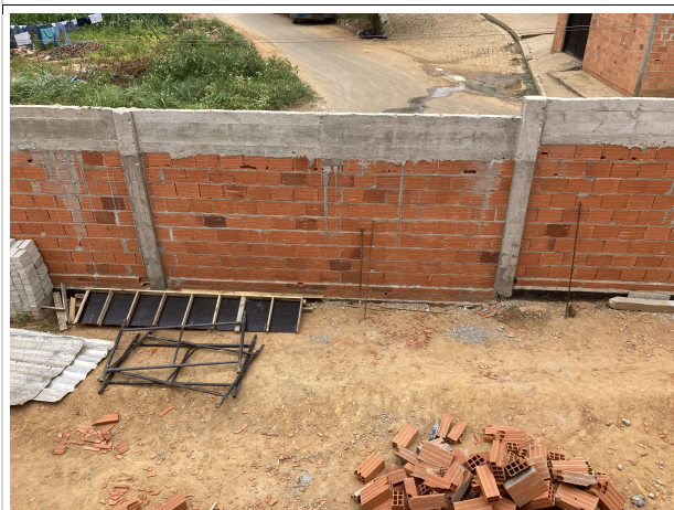
Fig. 11 – Execução de alvenaria e impermeabilização
