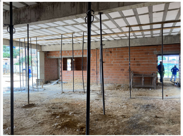
Fig. 4 – Execução de superestrutura
