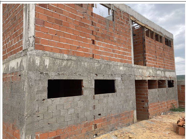
Fig. 12 – Execução de alvenaria e estrutura
