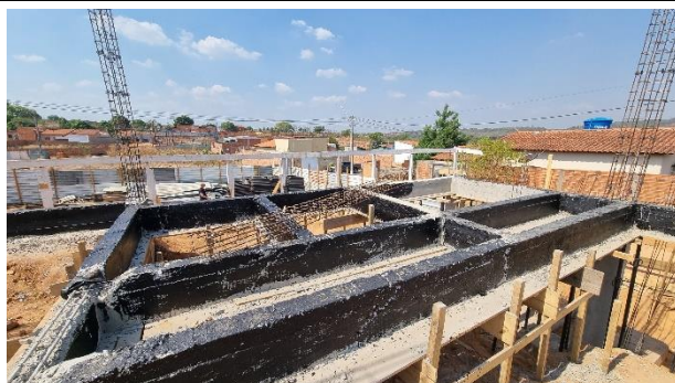
Fig. 7 – Infraestrutura (Baldrame/Impermeabilização)
