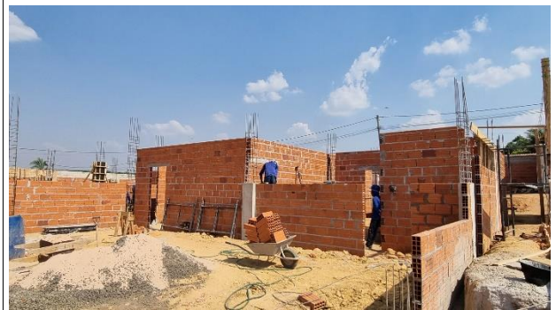
Fig. 10 – Alvenaria / Superestrutura
