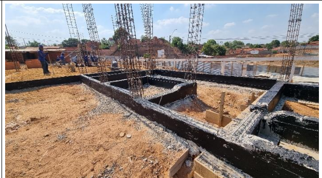
Fig. 6 – Infraestrutura (Baldrame/Impermeabilização)
