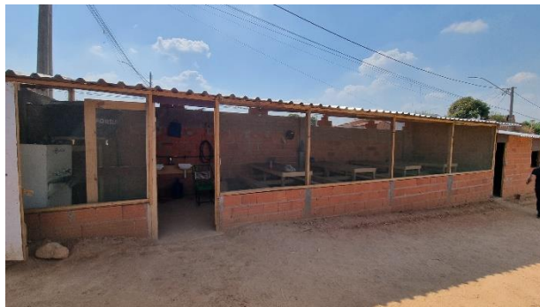
Fig. 1 – Serviços preliminares (Refeitório)
