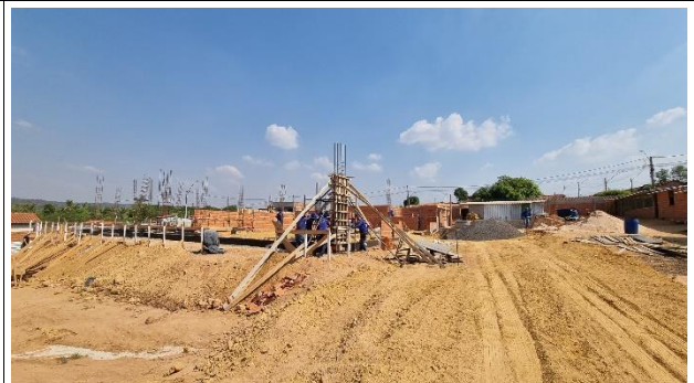
Fig. 4 – Movimentação de Terra (Corte/Aterro)
