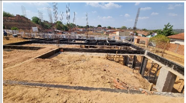
Fig. 8 – Movimentação de Terra / Infraestrutura (Baldrame/Impermeabilização)
