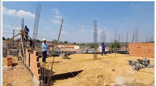
Fig. 2 – Serviços preliminares (Andaime)/ Administração
