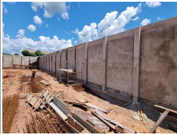
Fig. 9 – paredes e revestimento do muro de arrimo
