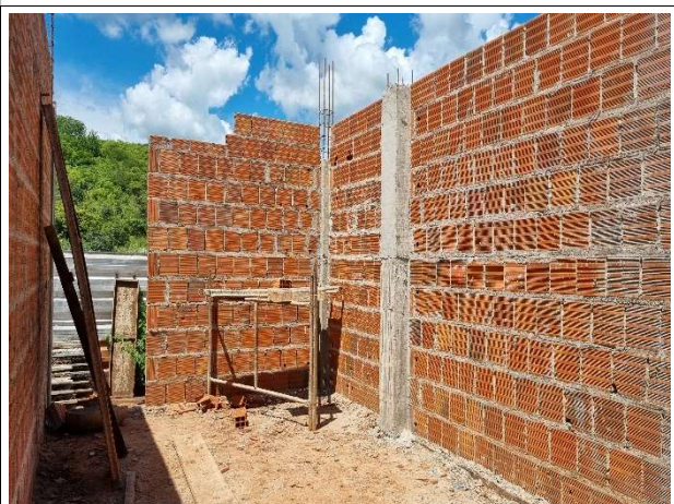
Fig. 8 – execução de alvenaria, vigas e pilares
