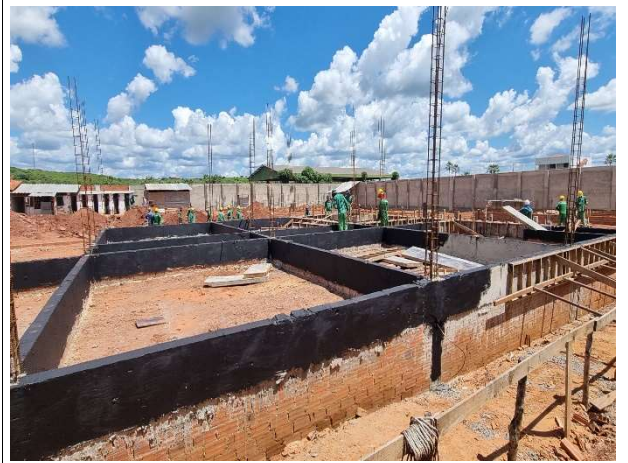
Fig. 10 – execução de vigas e preparação para pavimentação
