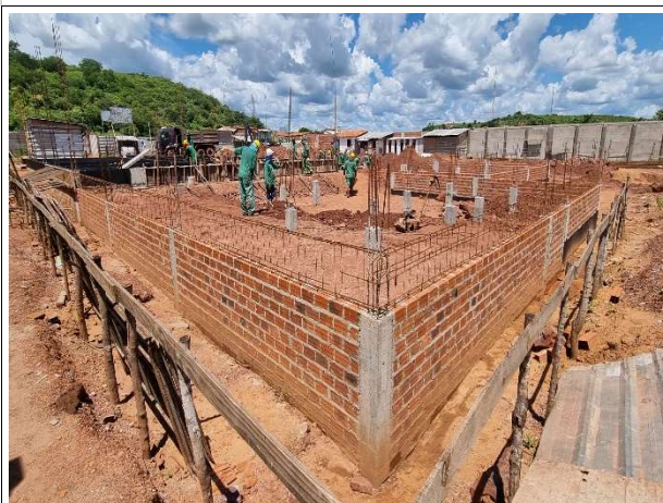
Fig. 7 – execução de alvenaria, vigas e pilares
