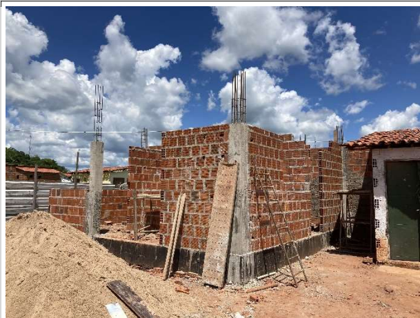
Fig. 5 – infraestrutura/superestrutura da guarita
