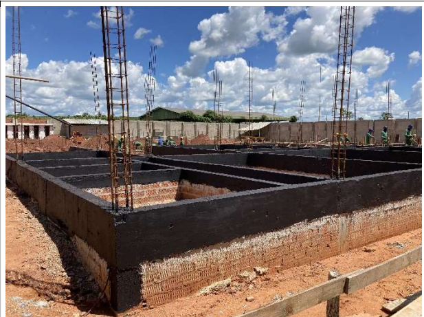
Fig. 6 – execução de impermeabilização de vigas
