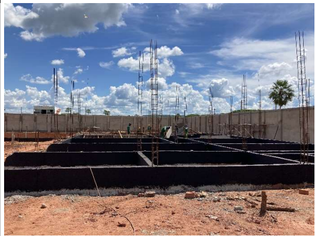
Fig. 4 – vigas impermeabilizadas e armação dos pilares
