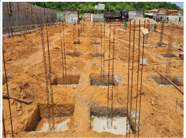
Fig. 4 – armação da superestrutura
