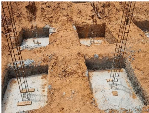
Fig. 3 – execução de fundações
