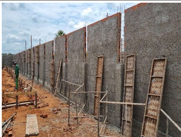
Fig. 5 – superestrutura do muro de arrimo
