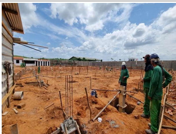
Fig. 7 – execução de fundações
