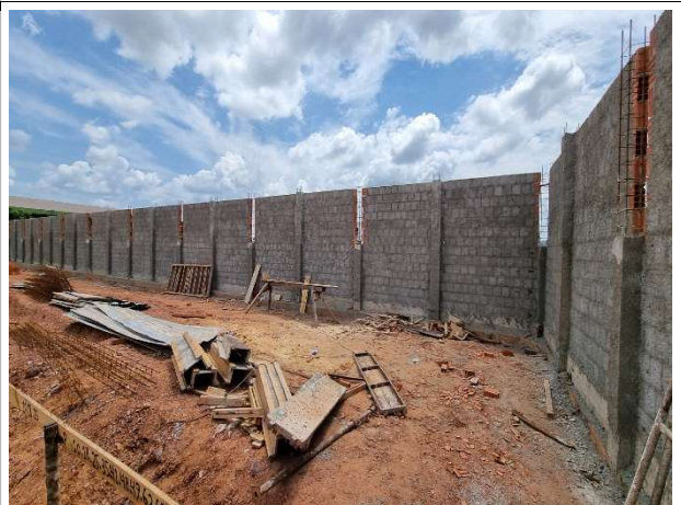
Fig. 6 – infraestrutura e superestrutura do muro de arrimo
