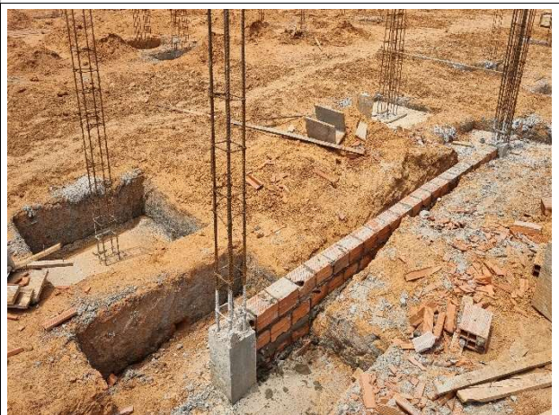
Fig. 8 – execução de fundações
