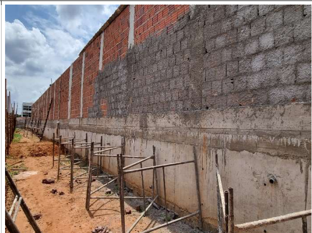
Fig. 6 – infraestrutura e superestrutura do muro de arrimo
