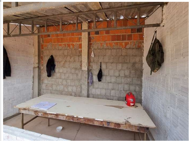
Fig. 4 – execução de canteiro de obras (serviço preliminar)
