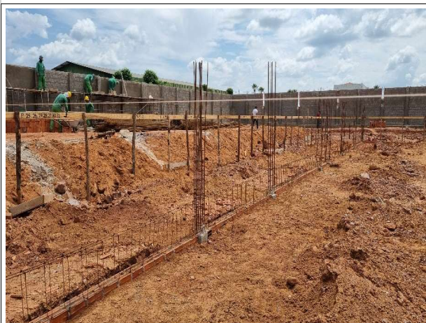
Fig. 7 – execução de baldrame e superestrutura
