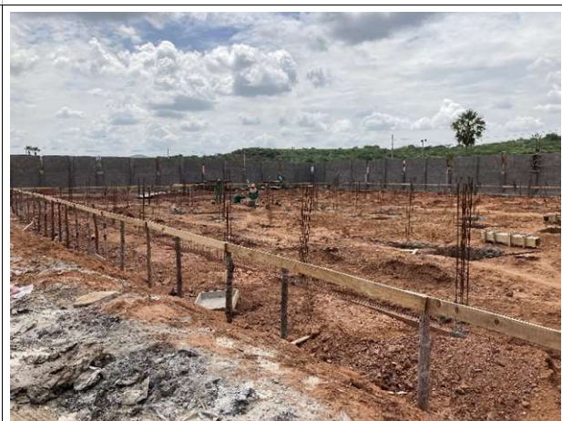
Fig. 8 – execução de locação de obra e movimento de terra
