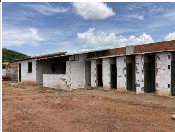
Fig. 3 – execução de canteiro de obras (serviço preliminar)
