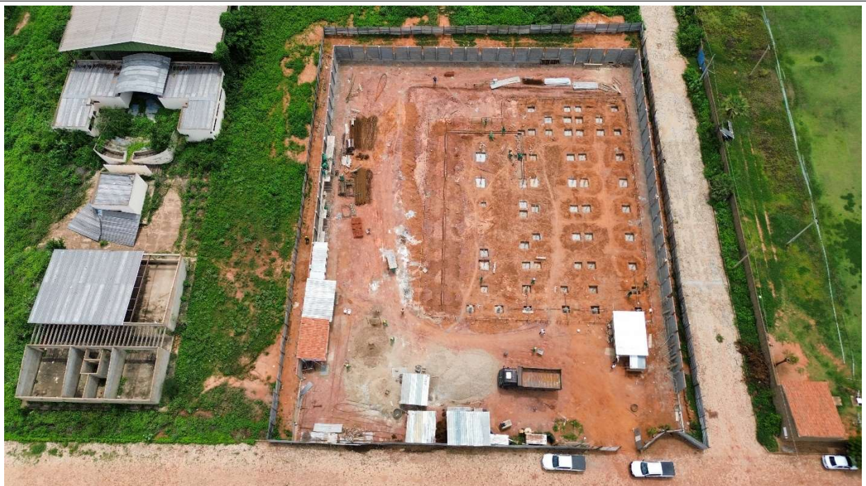
Fig. 2 – Vista aérea da obra
