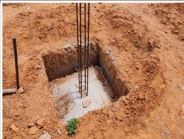
Fig. 5 – execução de infraestrutura (fundação)
