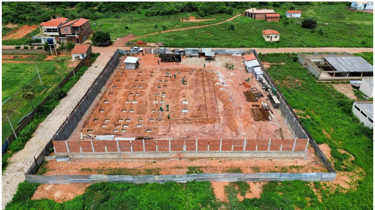
Fig. 1 – Vista aérea da obra
