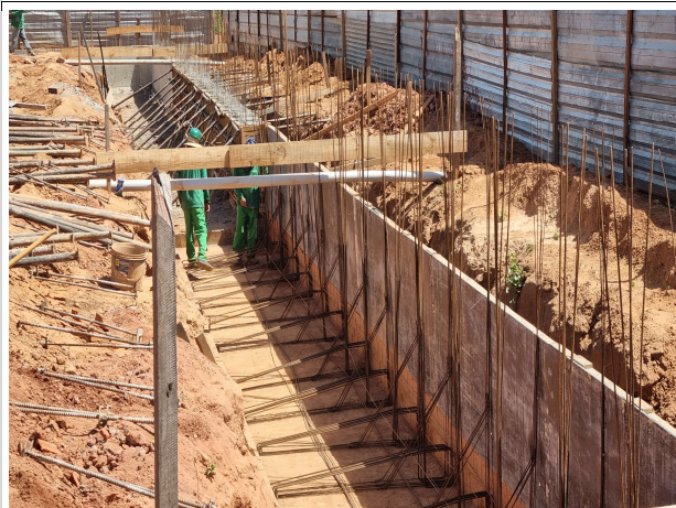
Fig. 5 – execução de muro de arrimo
