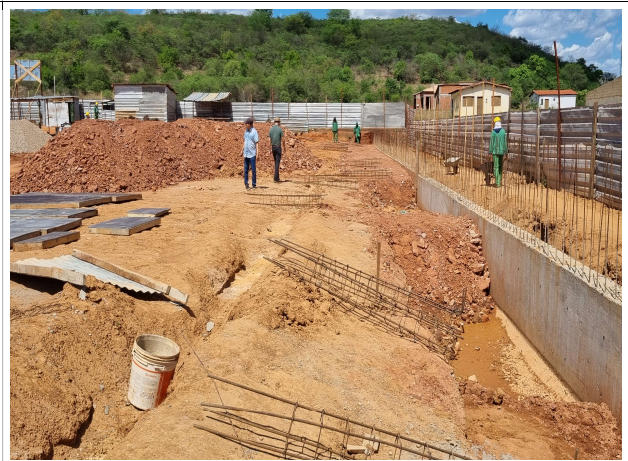
Fig. 6 – execução de infraestrutura de concreto
