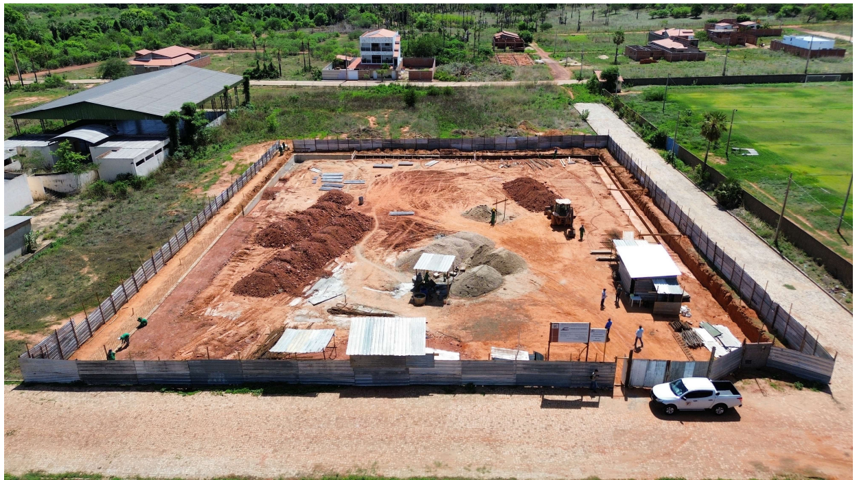
Fig. 1 – Vista aérea da obra
