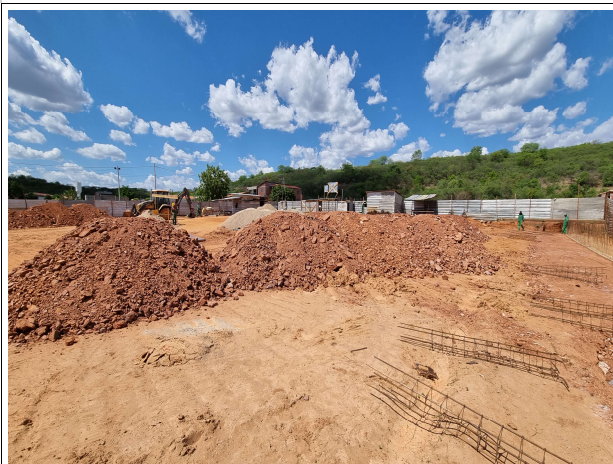
Fig. 7 – execução de movimentação de terra
