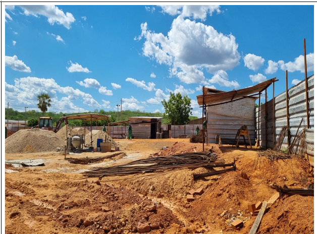
Fig. 8 – execução de instalações provisórias do canteiro
