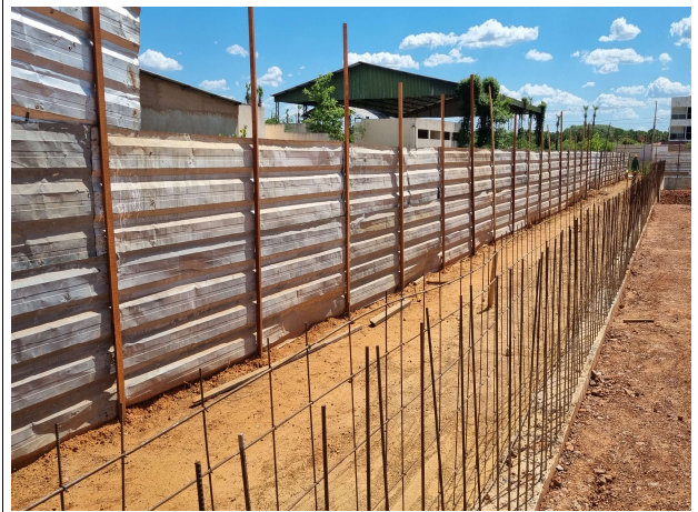
Fig. 10 – execução de muro de arrimo
