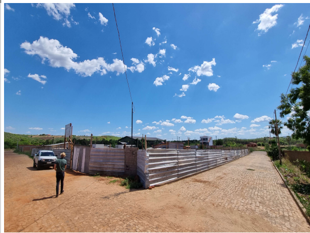
Fig. 3 – execução de tapumes (serviço preliminar)
