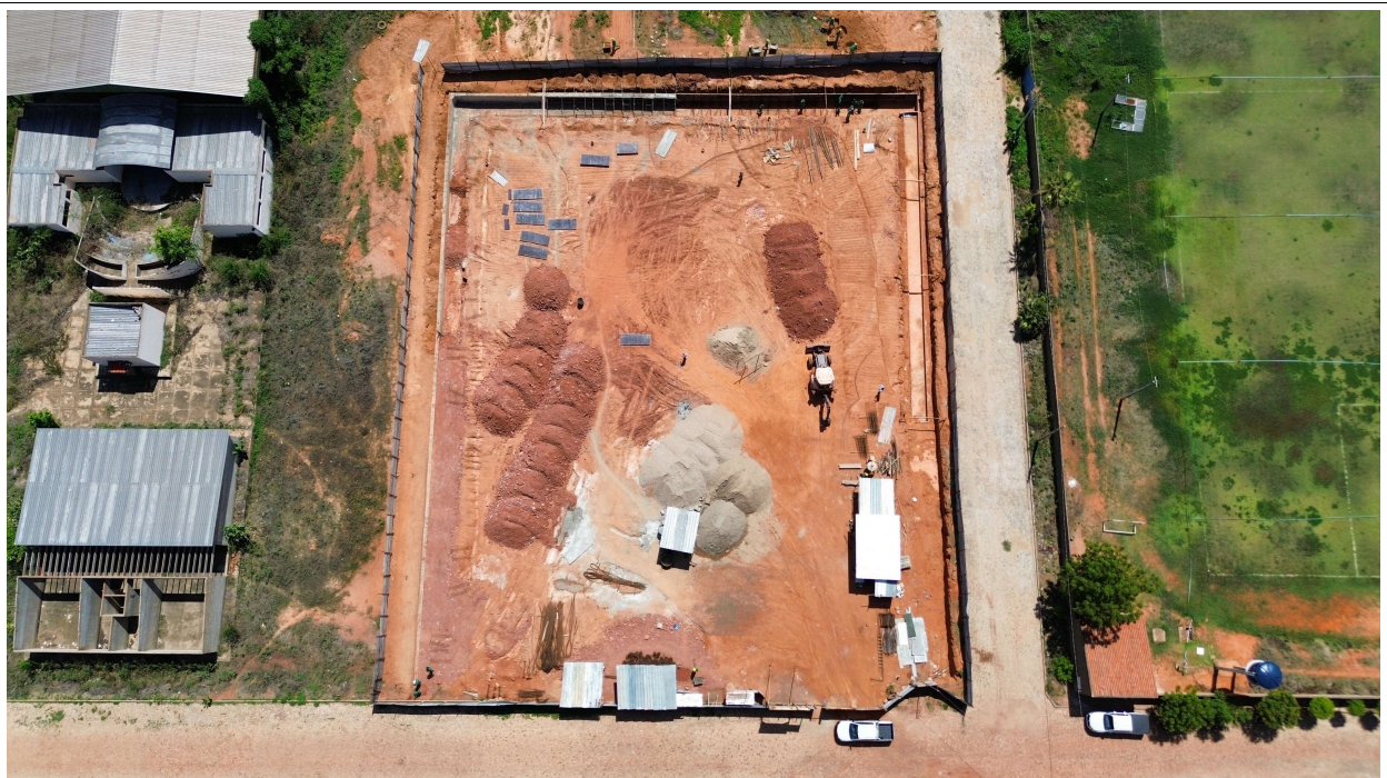
Fig. 2 – Vista aérea da obra
