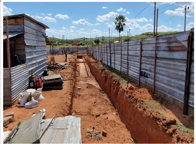
Fig. 4 – execução de escavações
