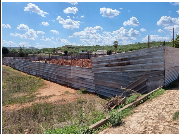
Fig. 9 – execução de tapumes (serviço preliminar)
