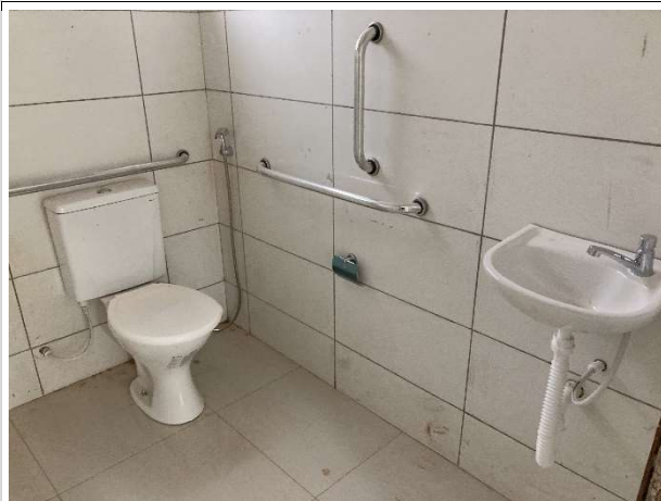
Fig. 11 – Revestimentos e instalações hidrossanitárias
