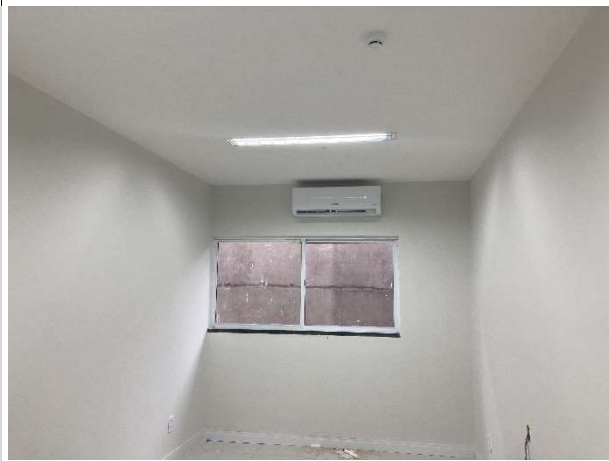
Fig. 9 – Pintura e instalações de ar condicionado
