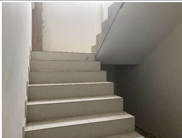
Fig. 17 – Aplicação de piso da escada
