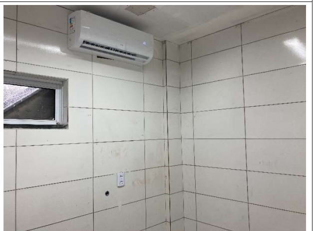
Fig. 20 – Execução de revestimentos
