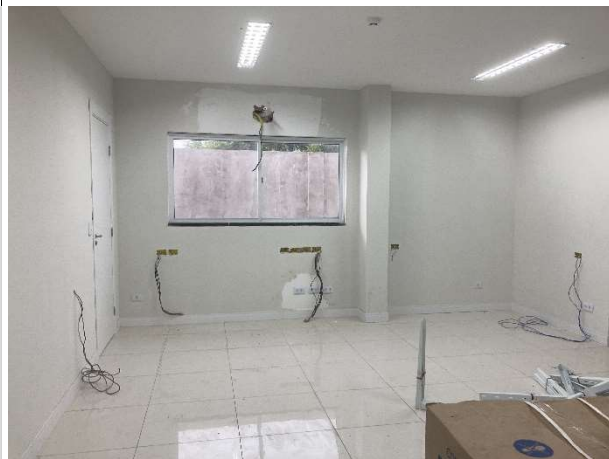
Fig. 3 – Pintura, esquadrias e instalações lógicas/elétricas
