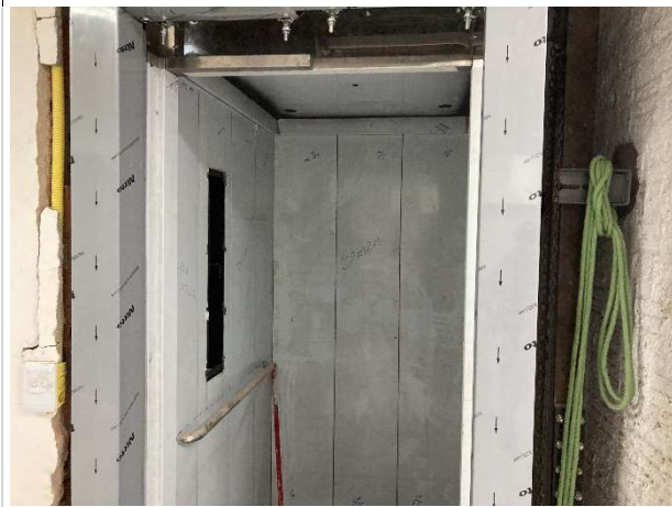
Fig. 15 – Cabine do elevador
