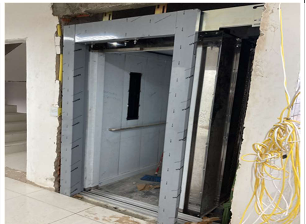
Fig. 16 – Montagem do elevador
