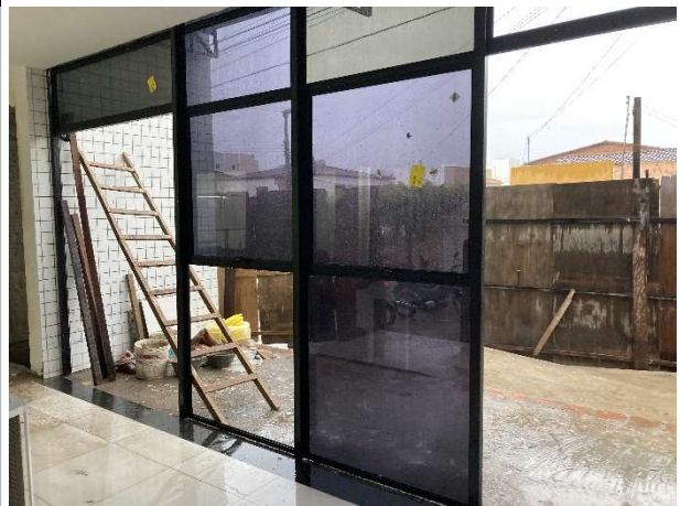
Fig. 4 – Esquadrias da fachada
