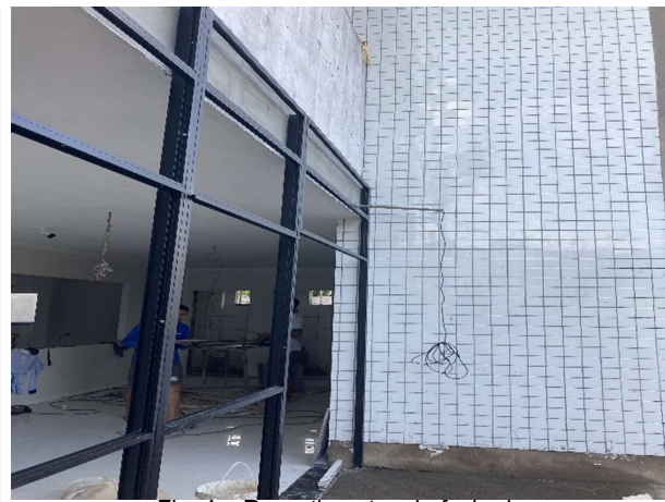
Fig. 4 – Revestimentos da fachada
