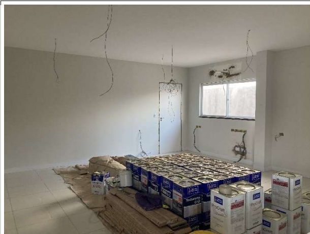
Fig. 5 – Execução de portas, janelas e instalações
