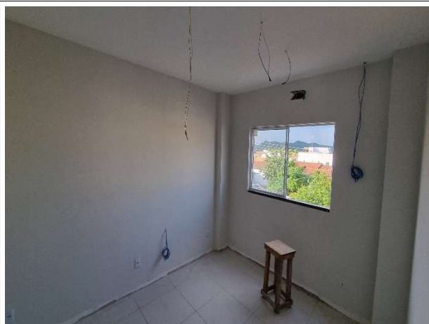
Fig. 6 – Execução de esquadrias e instalações
