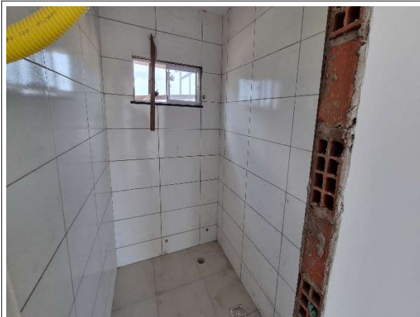
Fig. 11 – Revestimentos e instalações hidrossanitárias
