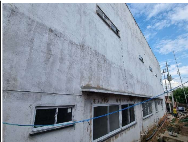
Fig. 7 – Execução de esquadrias
