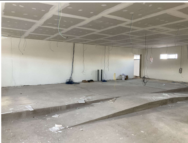
Fig. 7 – Execução de forro, paredes e instalações elétricas
