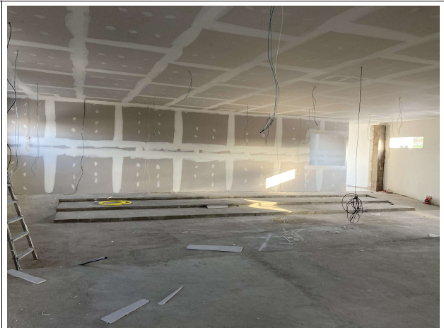
Fig. 8 – Execução de forro, paredes e instalações elétricas
