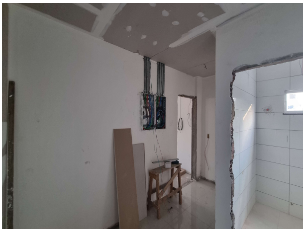
Fig. 5 – Execução de revestimentos e instalações
