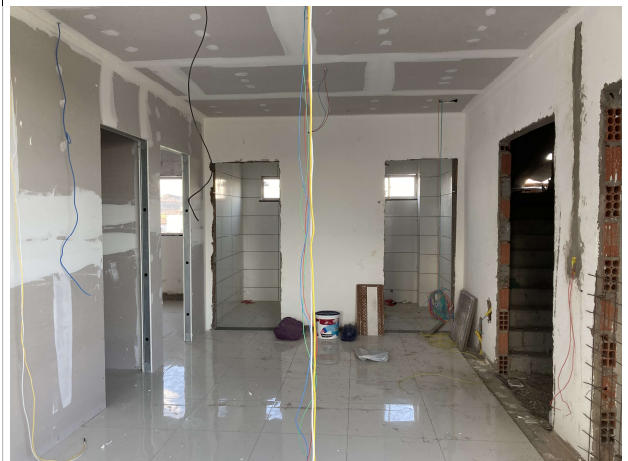
Fig. 6 – Execução de revestimentos e instalações
