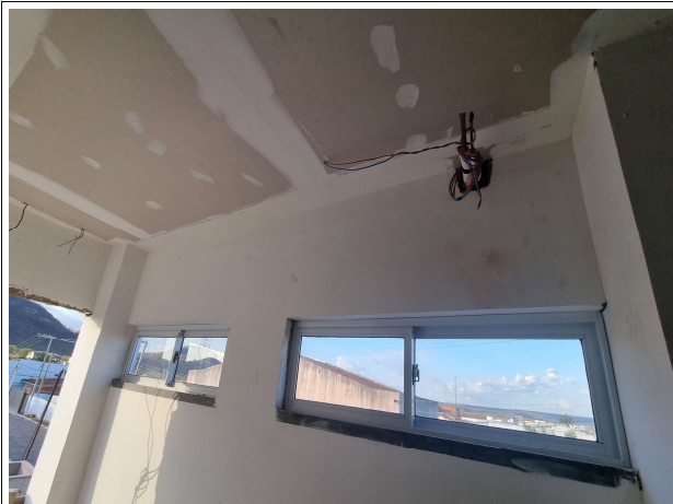
Fig. 11 – Execução de instalações e esquadrias
