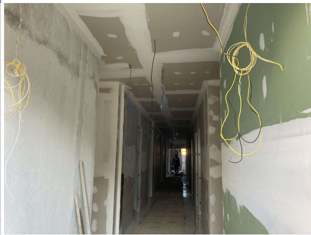
Fig. 9 – Execução de instalações elétricas
