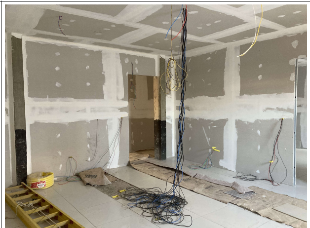
Fig. 8 – Execução de forro, paredes e instalações elétricas
