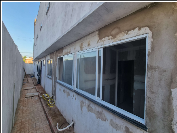
Fig. 11 – Execução de instalações e esquadrias
