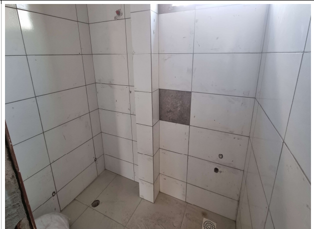
Fig. 6 – Execução de revestimentos e instalações hidráulicas
