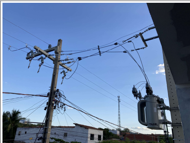
Fig. 7 – Execução de instalações elétricas
