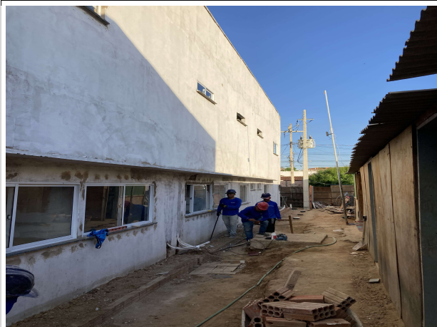
Fig. 5 – Execução de emassamento e janelas
