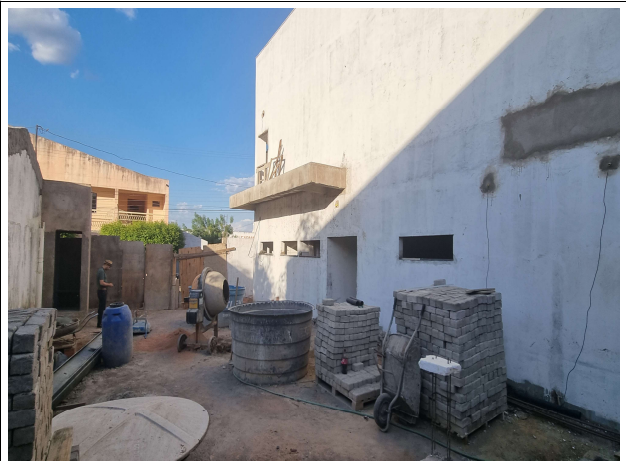
Fig. 12 – Remoção de entulho para assentamento de paver
