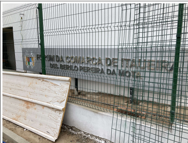
Fig. 13 – execução de gradil e tótem
