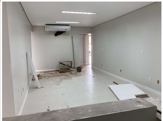
Fig. 10 – execução de forro, pintura e instalações
