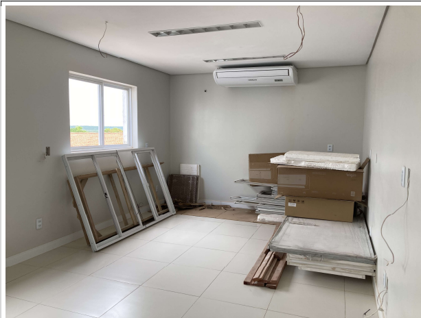
Fig. 5 – execução de instalações elétricas e climatização
