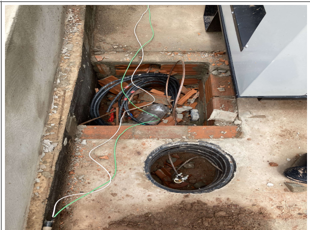
Fig. 18 – execução de SPDA
