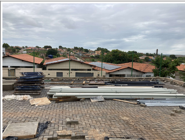
Fig. 7 – execução de pavimento intertravado e águas pluviais
