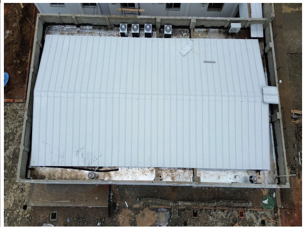
Fig. 4 – execução de cobertura e impermeabilização
