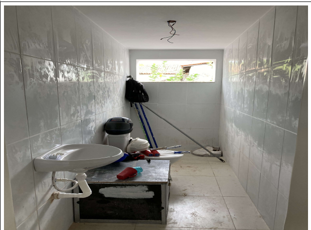
Fig. 8 – execução de revestimento e instalações sanitárias
