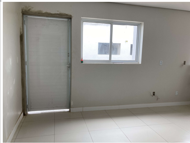
Fig. 15 – execução de piso, rodapé e esquadrias
