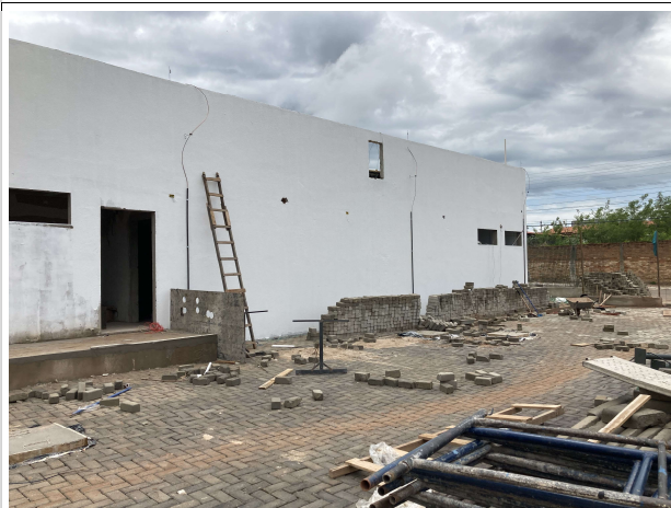
Fig. 11 – execução de pavimento intertravado, SPDA e pintura
