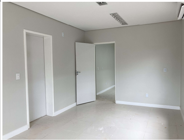
Fig. 9 – execução de forro, rodapé, pintura e esquadrias
