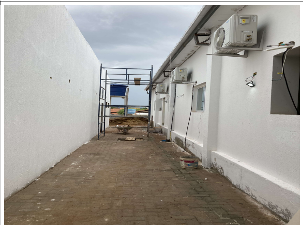
Fig. 12 – pintura e instalações de ar condicionado
