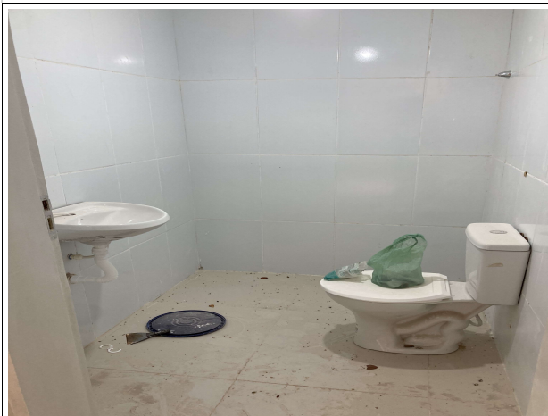
Fig. 17 – revestimento e instalações sanitárias
