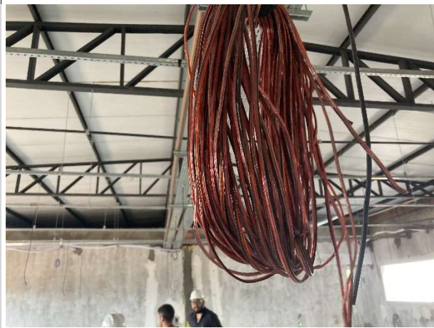
Fig. 9 – execução de instalações de sonorização
