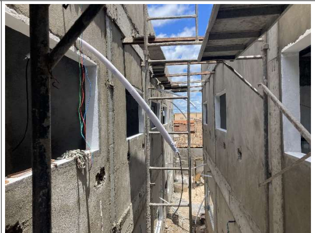
Fig. 8 – revestimento e instalações de climatização
