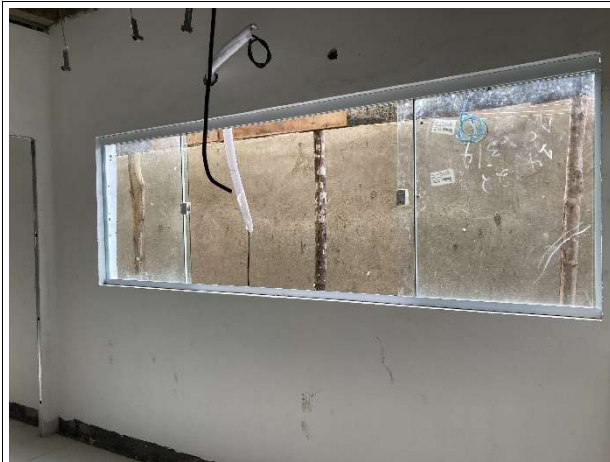
Fig. 7 – assentamento de esquadrias
