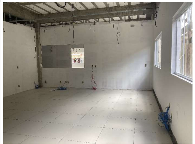
Fig. 4 – execução de piso, instalações e esquadrias
