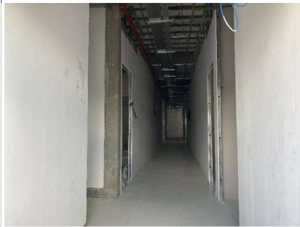
Fig. 3 – execução de paredes de drywall (diversos)
