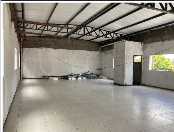
Fig. 5 – execução de piso e cobertura
