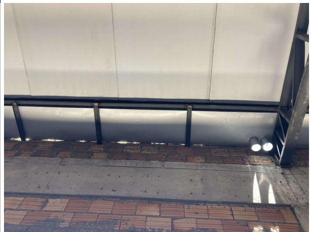
Fig. 5 – execução de calhas
