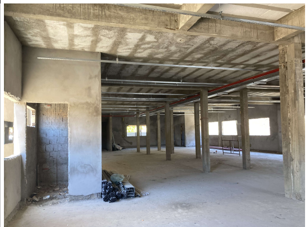
Fig. 7 – execução de contrapiso e revestimentos
