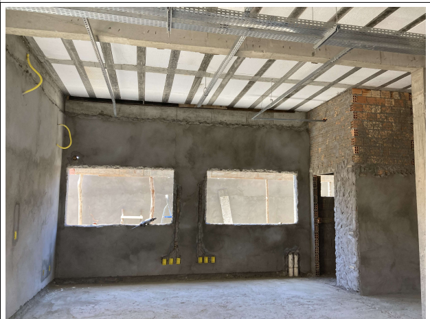
Fig. 9 – execução de instalação elétrica
