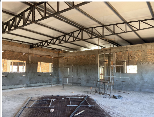
Fig. 4 – execução de alvenaria e estrutura metálica
