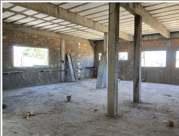
Fig. 2 – execução de superestrutura
