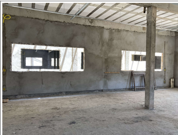
Fig. 8 – execução de alvenaria e revestimentos
