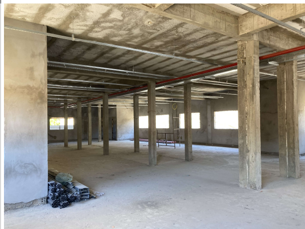
Fig. 6 – execução de instalação de combate a incêndio
