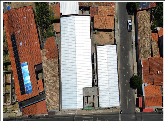
Fig. 3 – execução de cobertura
