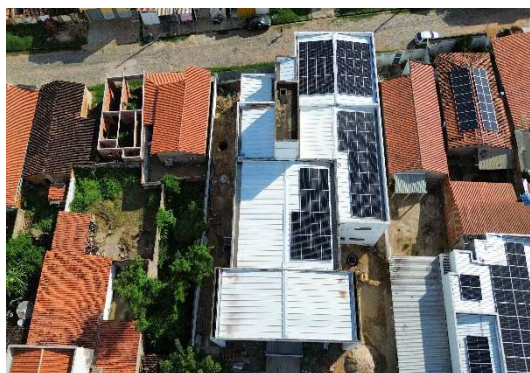
VISTA ÁEREA - COBERTURA
