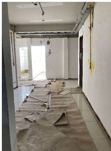
PISOS - REVESTIEMENTO - ELÉTRICA
