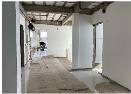
HALL PAVIMENTO SUPERIOR
