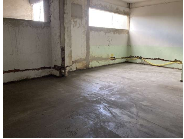
Fig. 8 – Pisos e revestimento.
