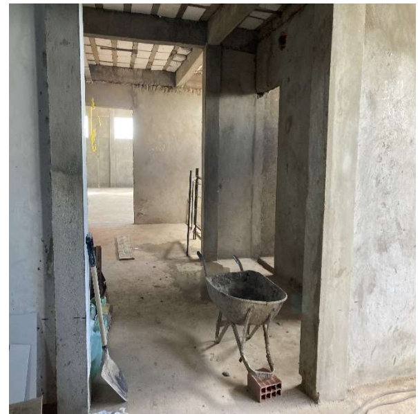
Fig. 6 – Pisos e revestimentos;
