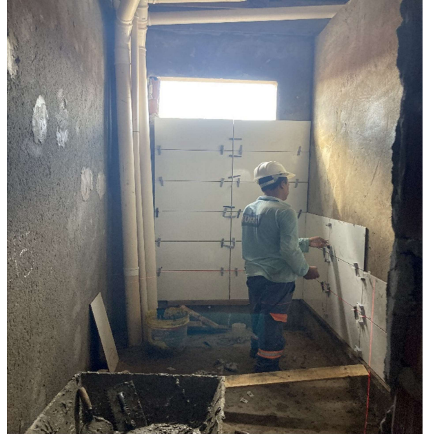
Fig. 4 – Instalações hidráulicas e revestimentos;
