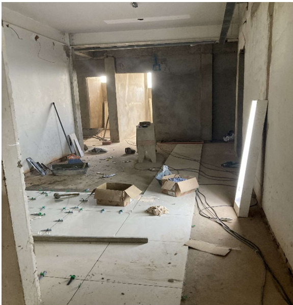
Fig. 5 – Pisos e revestimentos;
