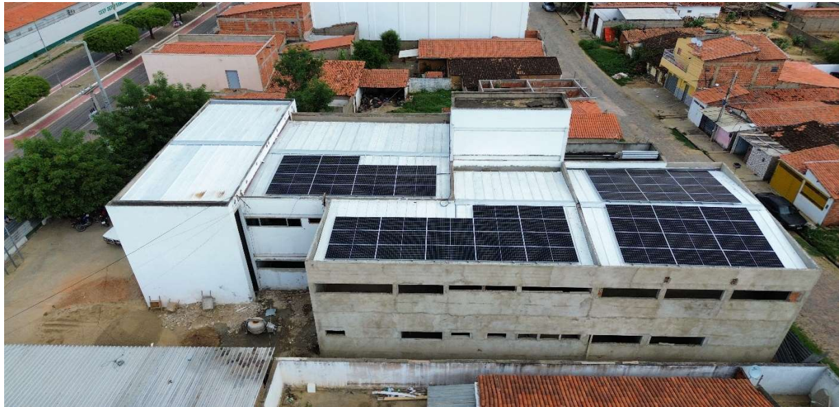
Fig. 1 – Execução de cobertura;
