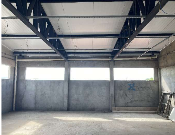
Fig. 7 – Cobertura, pisos e revestimento;
