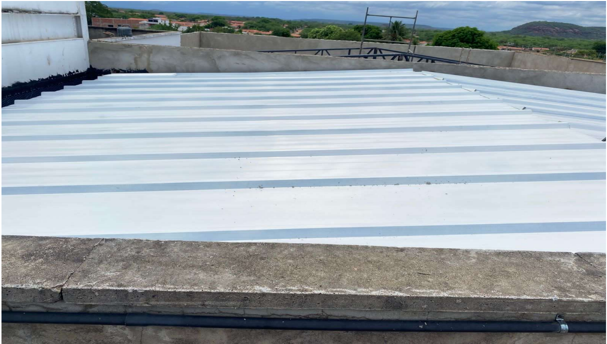
Fig. 1 – Execução de cobertura
