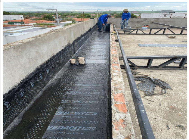
Fig. 4 – execução de impermeabilização de calha
