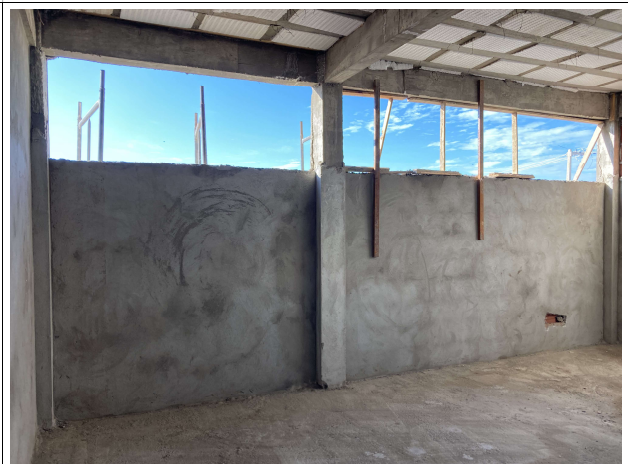
Fig. 8 – execução de alvenaria e revestimentos
