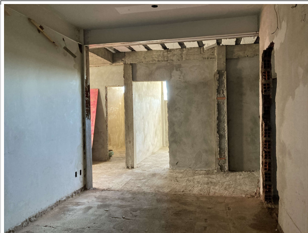
Fig. 5 – execução de alvenaria e revestimentos
