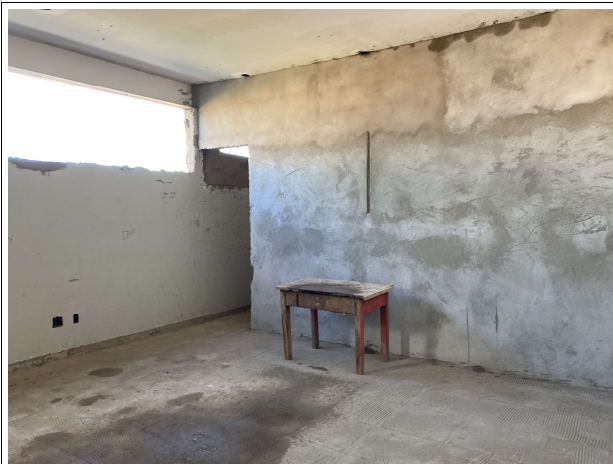
Fig. 7 – execução de alvenaria e revestimentos
