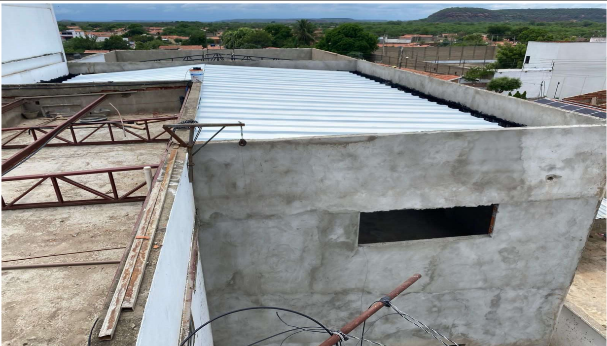
Fig. 2 – Execução de cobertura, alvenaria e revestimentos
