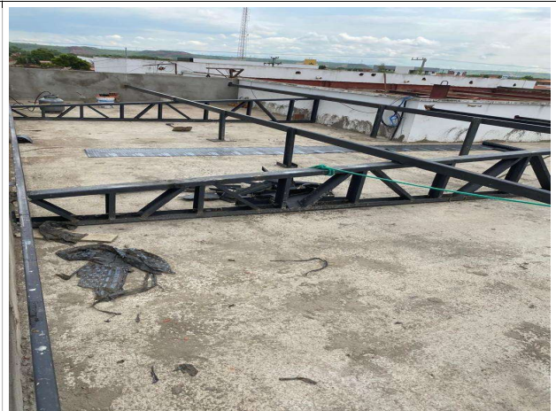
Fig. 6 – execução de estrutura metálica da cobertura
