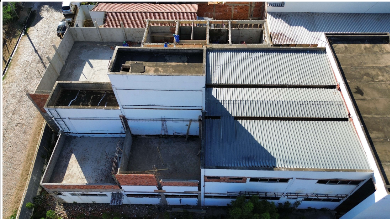
Fig. 1 – Vista aérea da obra em 10/10/2023
