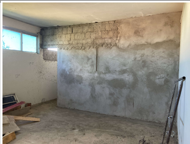
Fig. 5 – execução de alvenaria e revestimentos
