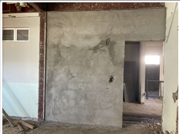
Fig. 6 – execução de revestimentos
