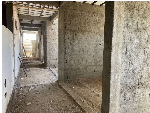
Fig. 9 – execução de alvenaria e revestimentos
