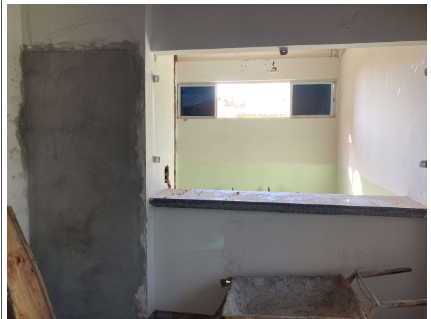
Fig. 10 – recomposição de alvenaria
