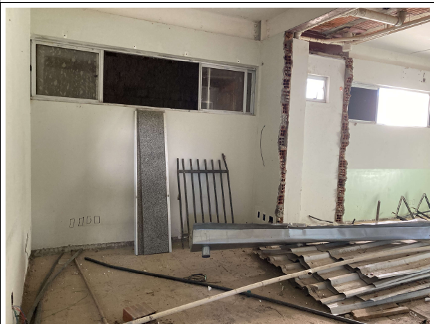
Fig. 8 – execução de demolições
