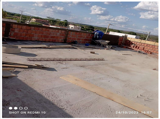
Fig. 4 – execução de laje da cobertura
