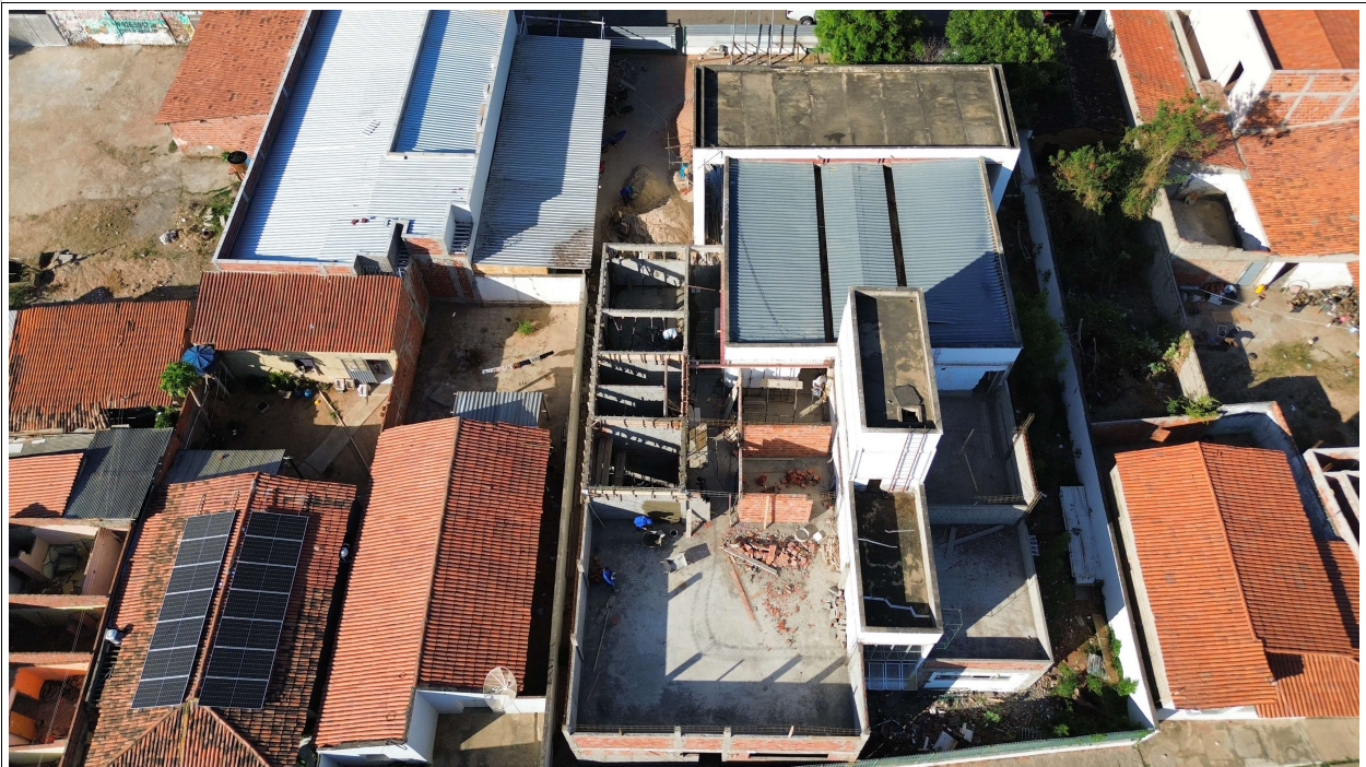
Fig. 2 – Vista aérea da obra em 10/10/2023
